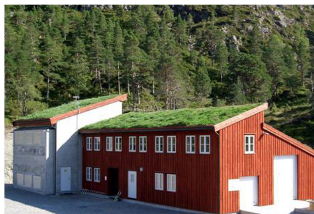
Figur 6-5 Eksempel på driftsbygg i kombinasjon med transformatorstasjon. Eksemplet er fra vindparken på Hitra (Foto: Trond Simensen, SWECO)
