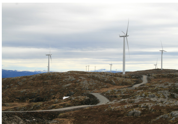
Figur 6-4 Eksempel på internvei (fra Hitra Vindpark) (Foto: Trond Simensen, SWECO)
