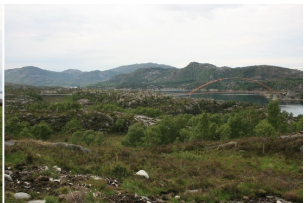
Figur 11 Brandangersund bru sett mot øst fra den nye fylkesvegen på Sandøy
