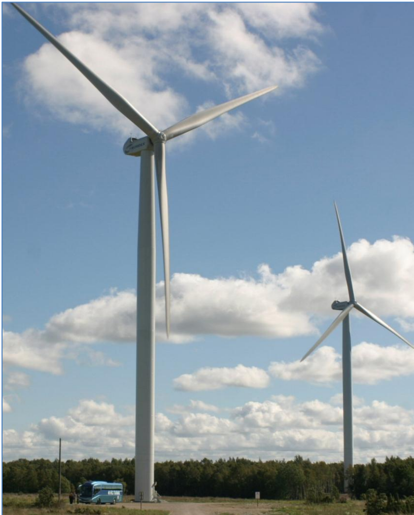
Figur 4. Eksempel på vindturbiner som kan være egnet for Raskiftet vindkraftverk. Tårnet i aktuelle vindturbiner er ca. 90-120 m høyt og hvert vingeblad er ca. 40-60 m langt. Foto: Sweco.
