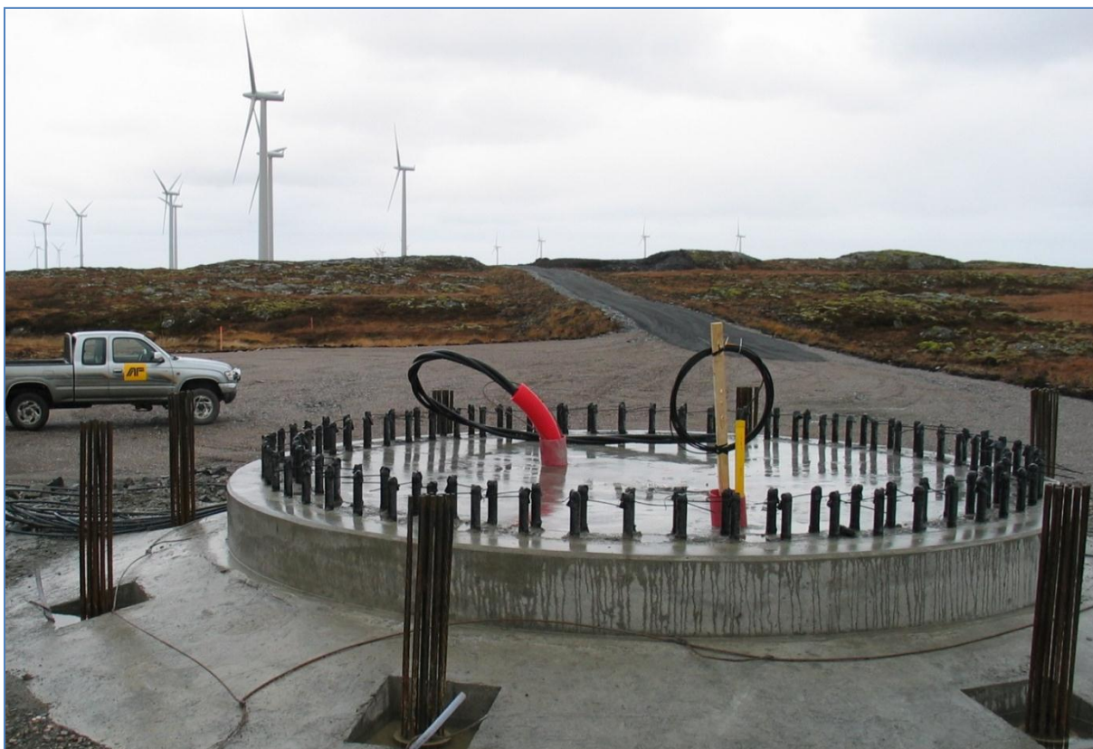
Figur 5. Eksempel på fundament til vindturbin, oppstillingsplass og veger. Foto: Odd Sigmund Brøste.
