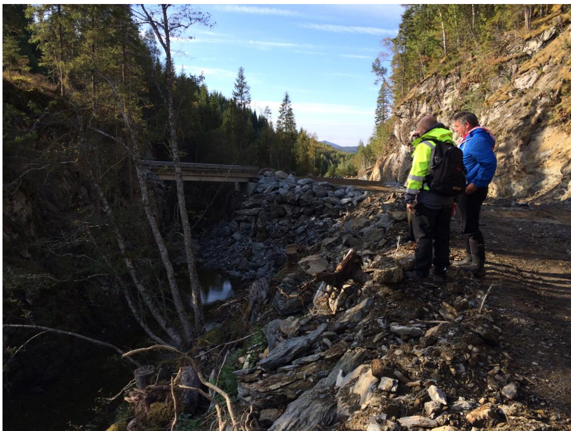
Figur 8: Bilde fra tenkt damsted og ned til ny bro.
