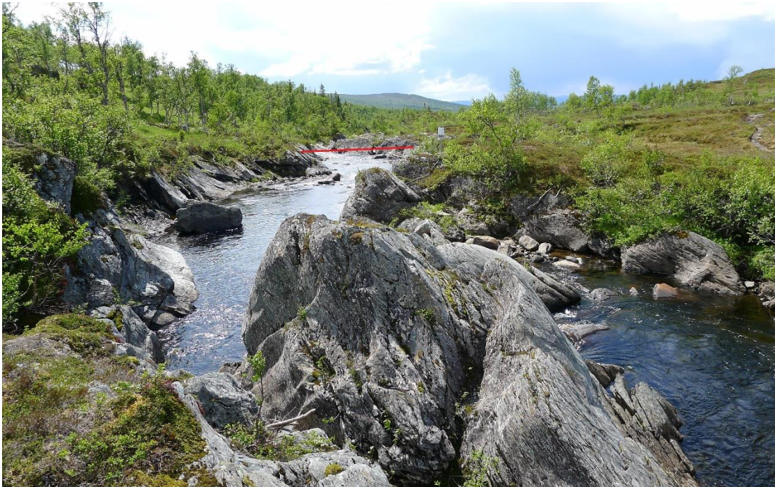
Figur 7: Rød strek viser plassering av dammen. Bildet er tatt fra gangbroa oppstrøms inntaksområdet
