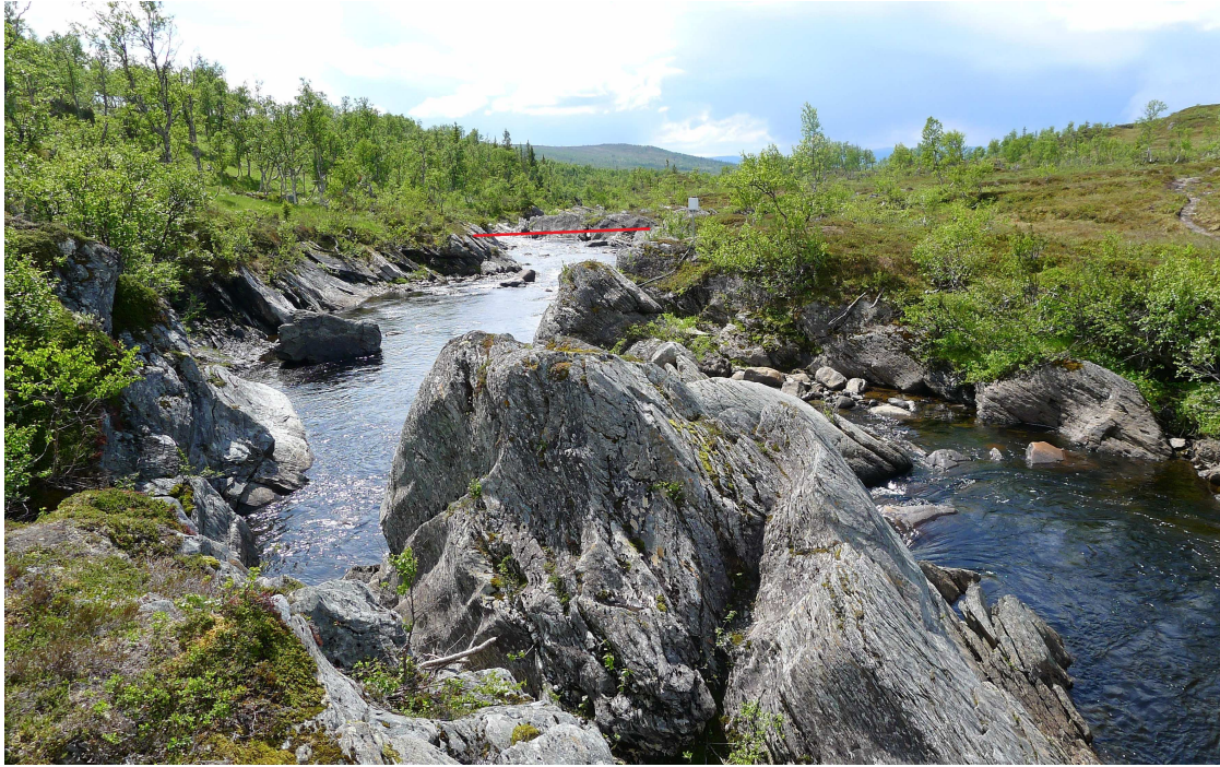
Bilde av inntaksplassering. Rod strek viser plassering av dammen. Bildet er tatt fra gangbroa oppstrøms inntaksområdet
