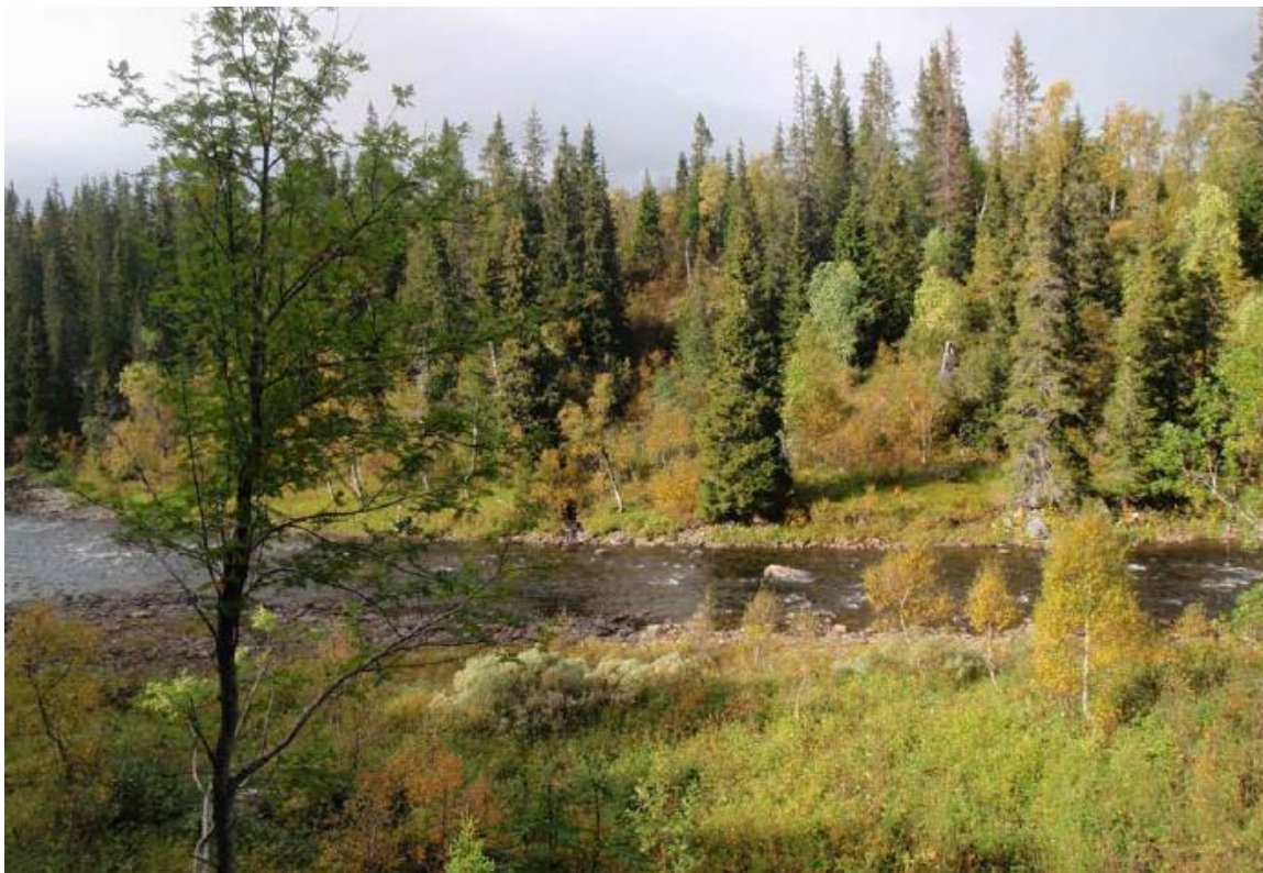
Figur 9: Bildet viser stasjonsområdet på motsatt side av elva. I forgrunnen kommer stikkvegen til stasjonsområdet ned. Det vil bli bygget bro over til stasjonsområdet over elva.
