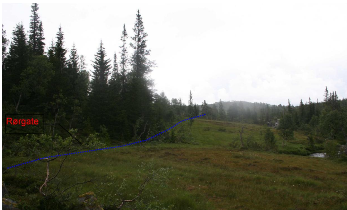
Figur 4: Bilde som viser trasen ca. 700 meter oppstrøms traseen. Bildet er tatt oppover.
