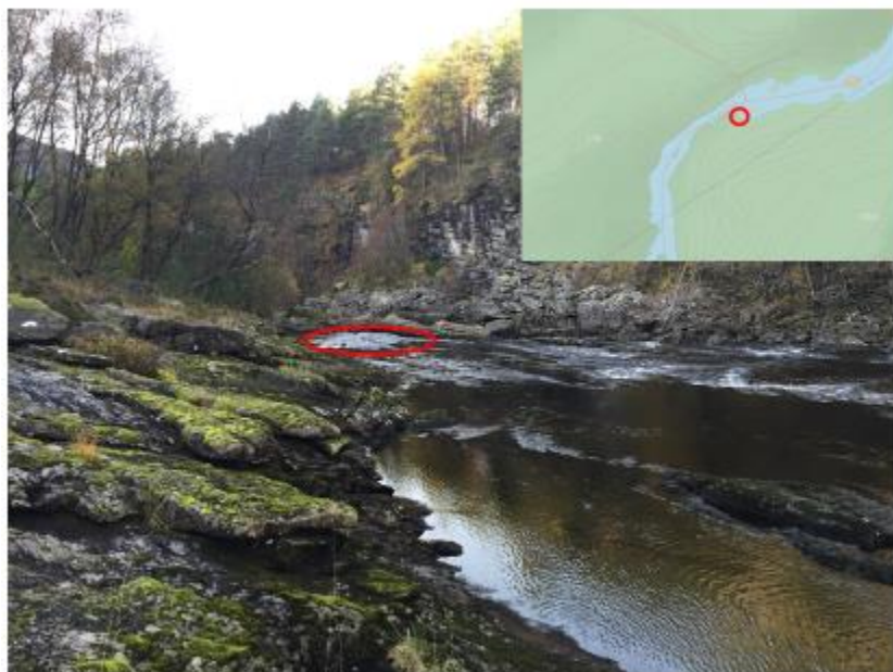
Figur 7. Kulp som vert brukt til inntak for kraftverket.
