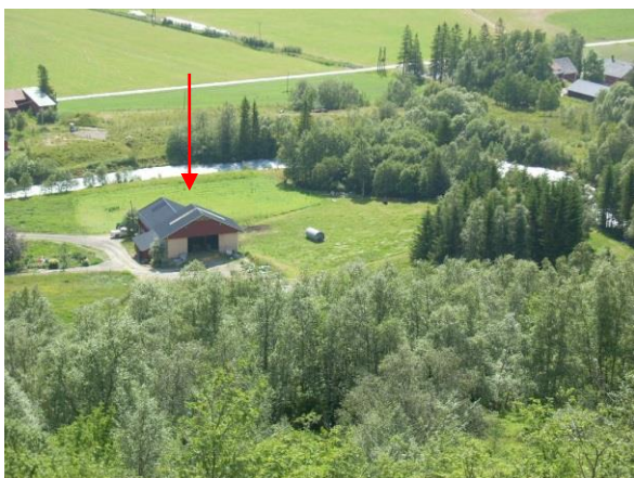
Kraftstasjonstomta på dyrka mark ved Åmot
