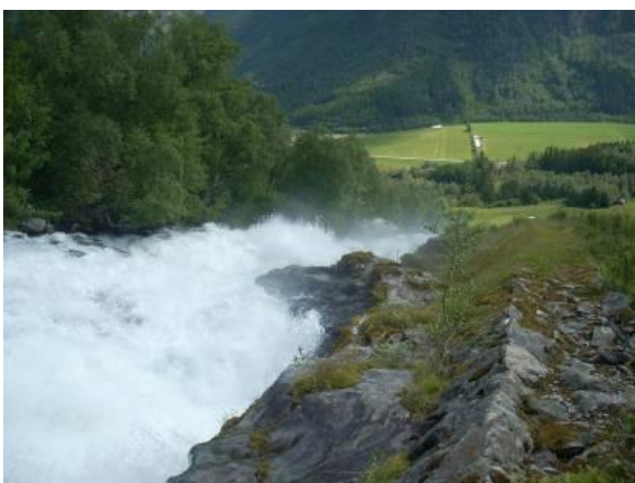
Flomforbygning oppstøms Høyset Camping
