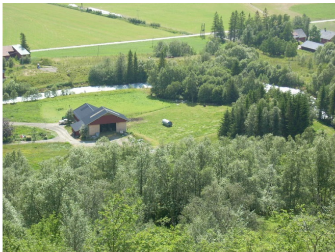
Bilde 05 – Kraftstasjonen blir liggende på innmark bak låven på bildet
