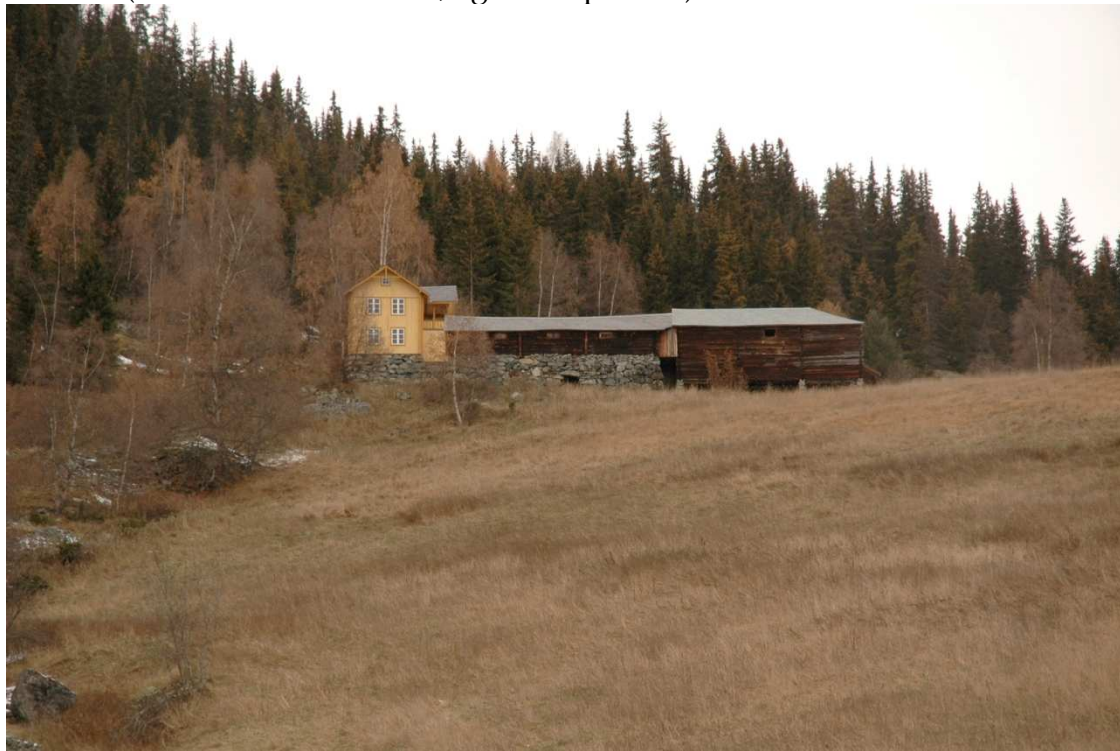
2 Tunet på Belsheim sett frå jorda nedanfor. Foto tatt mot nord
