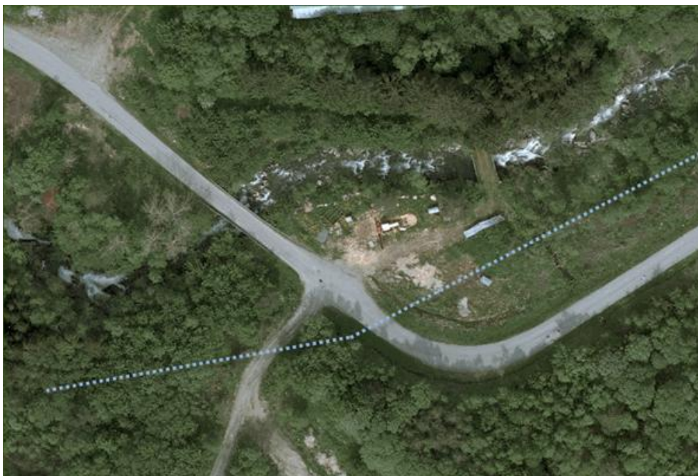
Figur 3.7.3 Luftfoto viser den gamle steinkvelvingsbrua nedanfor Hatlebakken og røyrtrase.
