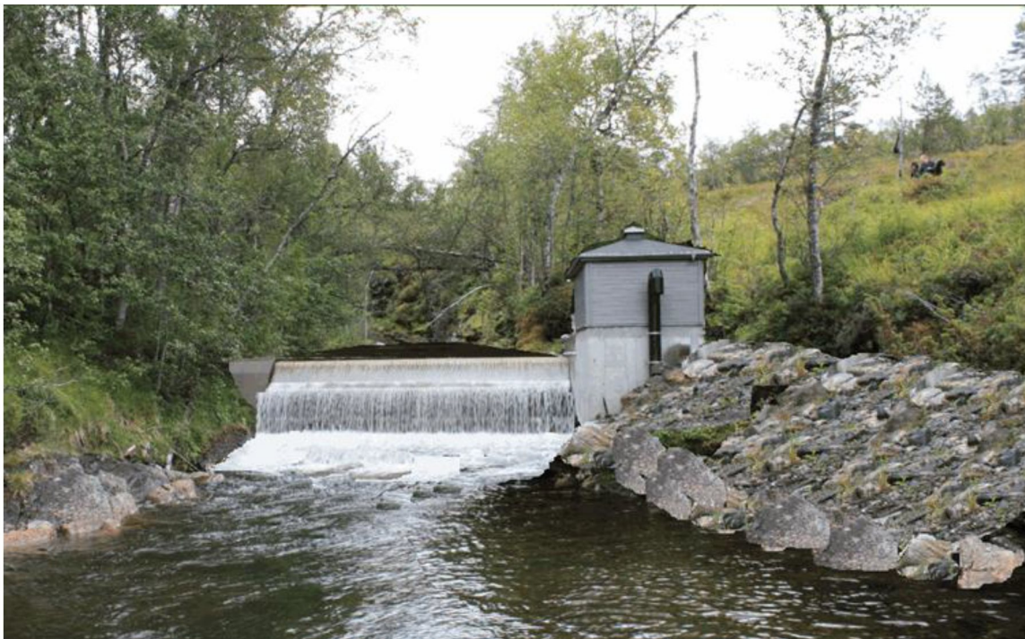
Figur 2.2.4.2 Visualisering av eit coandainntak på inntaksstaden.
