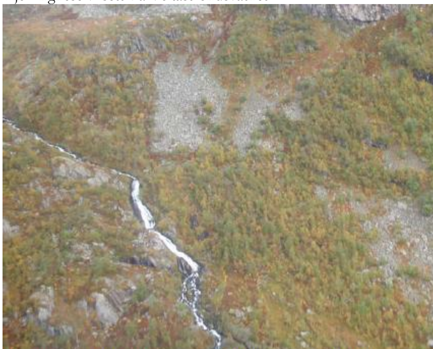
Kjerringneselva nedstrøms inntak og dam, sett fra helikopter
