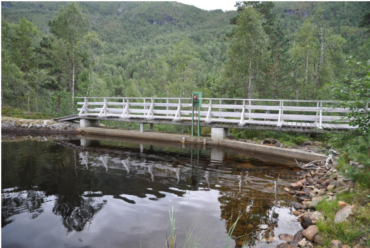
Figur: Eksisterende dam ved utløpet av Vassendvatnet.
