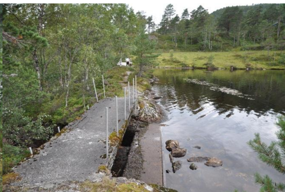
Figur 5: Eksisterende dam, sperredam øst, hoveddam i bakgrunn.
