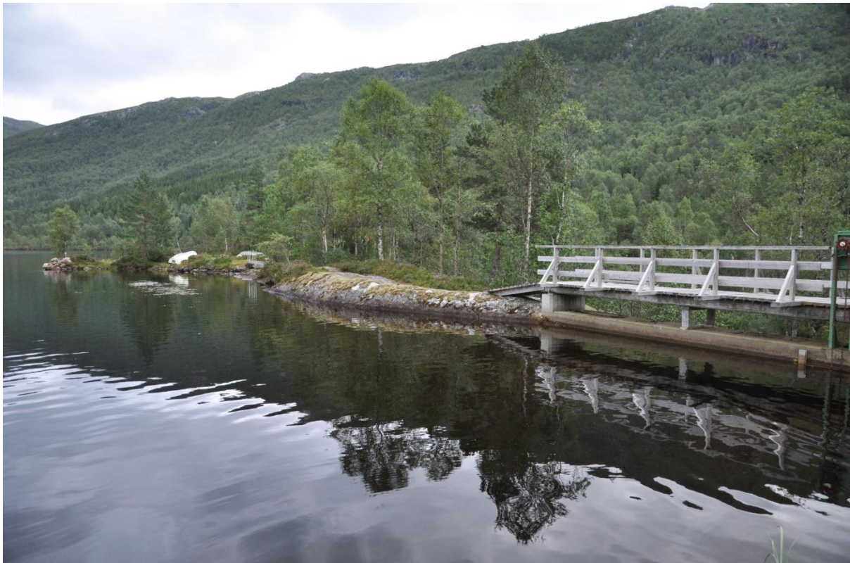
Figur: Eksisterende dam, sett fra nordsiden.
