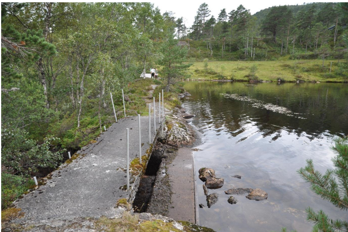
Figur: "Sperredam" sør for eksisterende dam. Bildet er tatt mot nord (mot eksisterende dam).
