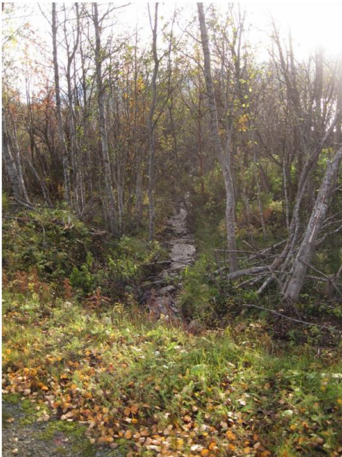
Mindre bekk hvor vannet fra kraftstasjonen får utløp i stikkrenne under Fv293.
