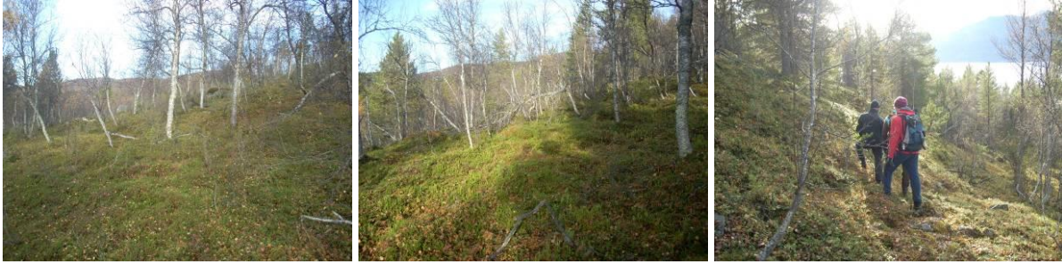
Bildene over viser deler av rørraseen fra Leirbuktelva nedover mot nedre felles rørrase.
