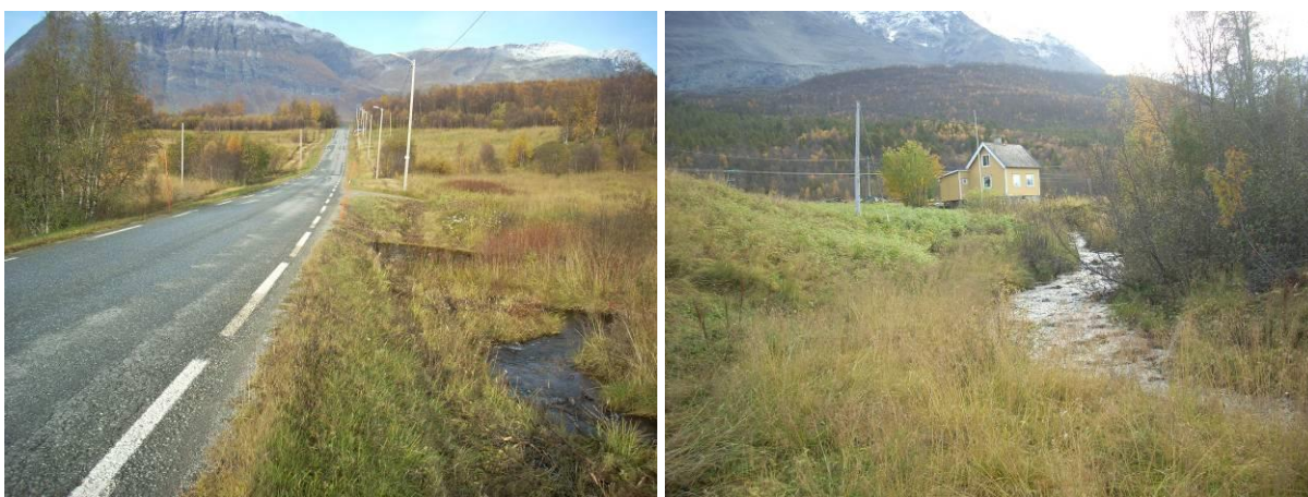
Figur 8: Bildene over viser Fv293 som krysser elvene oppstrøms utløp, samt hus og 22 kV linje langs nedre del av Leirbuktelva. Fotos: Ole Roer.
