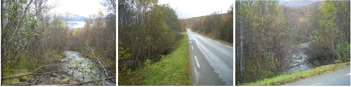
Bildene over viser Rastelva der den krysser under Fv 293 ned mot utløpet.
