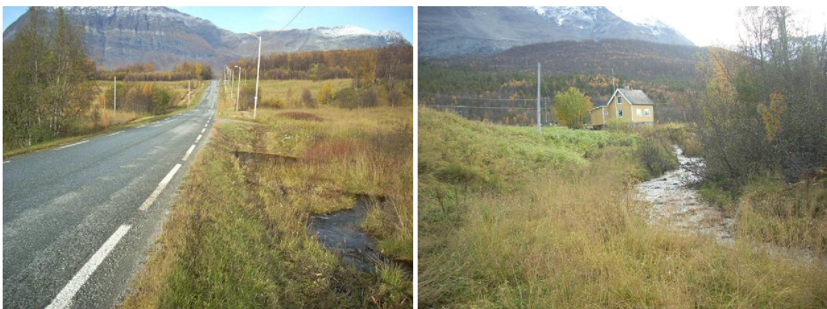
Figur 2: Fylkesvei 293 som krysser elvene oppstrøms utløp et (venstre), samt hus og 22 kV linje langs nedre del av Leirbuktelva (høyres). Fotos: Ole Roer.
