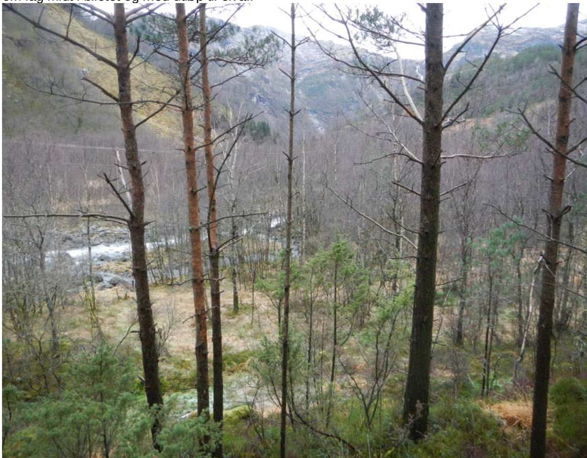
Figur 2.2.4.1 Kraftstasjonen får utløp i venstre billedkant til elva.
