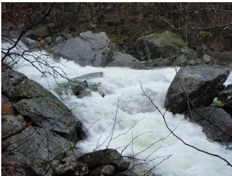
Figur 15. Store blokker rett nedenfor planlagt inntak.
