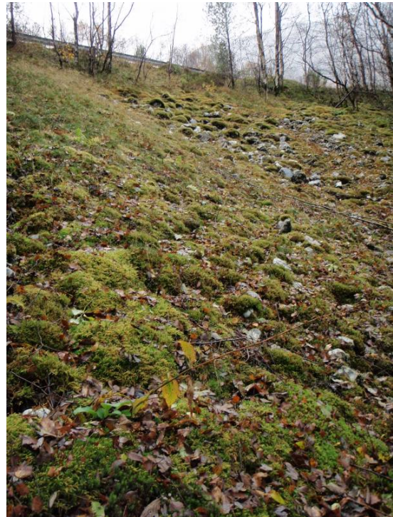
Figur 10. Mosekledd ur fra veiskulder og ned skråningen mot stasjonsområdet.
