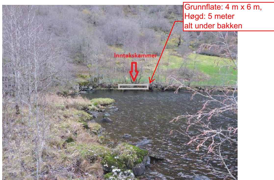
Figur 10. Skisse som viser plassering av inntakskammeret.
