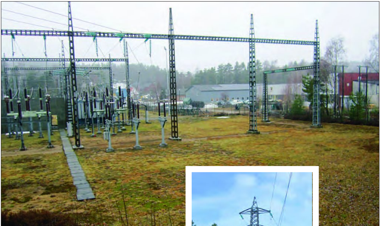
FIGUR 6: FOTO AV MOEN TRAFOSTASJON MOT SØRVEST. MULIG LEDIG Plass TIL NYE 132 KV FELT E18 VINDPARK I NORDRE DEL AV STASJONEN.
