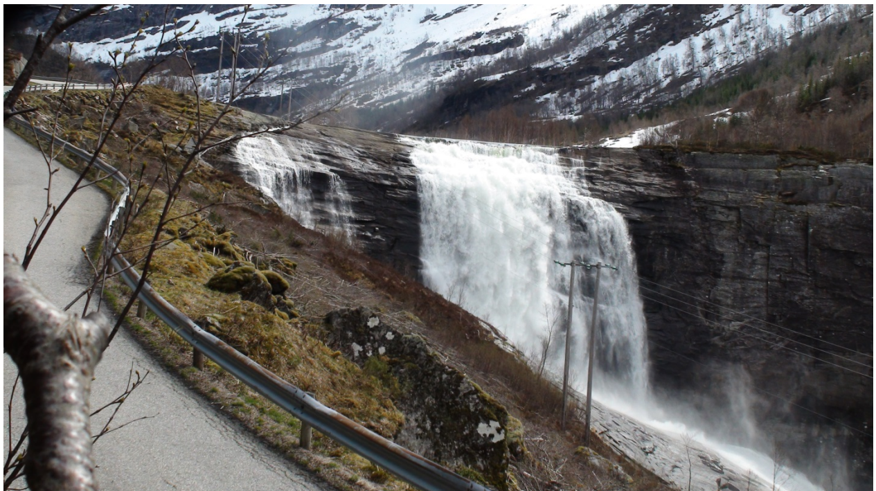
Figur 13: Fossfossen med ei estimert vassføring på ca. 12 m 3 /s - tilsvarande gjennomsnittleg sommarvassføring etter utbygging av Beinhelleren pumpe alternativ E. Foto tatt 12. mai 2012.
