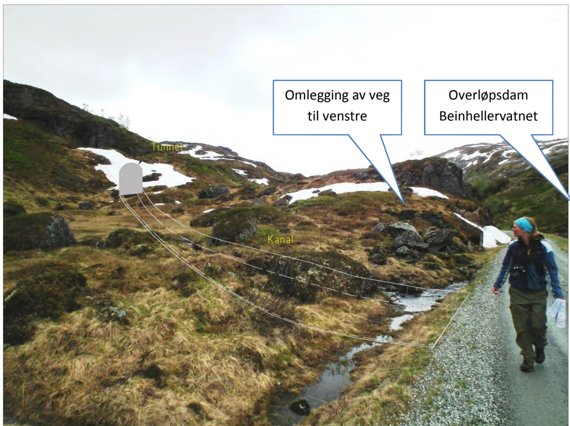
Figur 5: Overføringstunnel frå Kvanndalselvi på Beinhellersida. Det er planlagt ein kanal frå tunnelmunninga til Beinhellervatnet (som ligg utanfor høgre biletekant). Kanalen vil krysse vegen i ein kulvert. Dagens veg vil truleg måtte leggst om for å få plass til damarbeidet.
