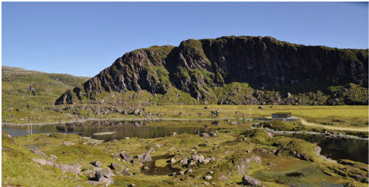
Figur 4: Illustrasjon av pumpestasjon ved Beinhelleren. Stasjonen er planlagt plassert mellom øvre og nedre Beinhellervatnet. Illustrasjonen viser ein ca 1 m reguleringssone (grått belte rundt vatnet). Linja frå stasjonen er den nye, planlagde 22 kV-linja, medan linja til venstre i bildet er den eksisterande linja som går der i dag.
