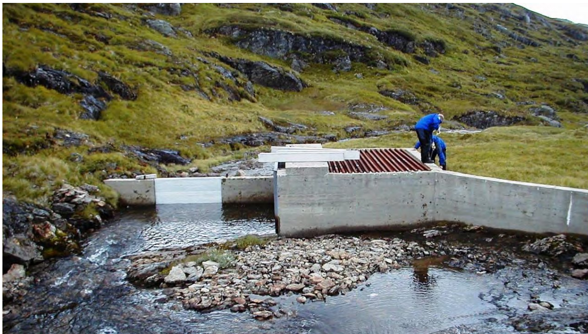
Figur 60: Bekkeinntaket i Beinhellerbekken
