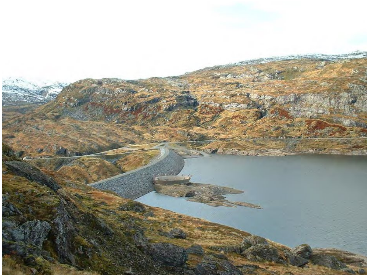
Figur 35 Askjellsdalsvatnet dam og overløp
