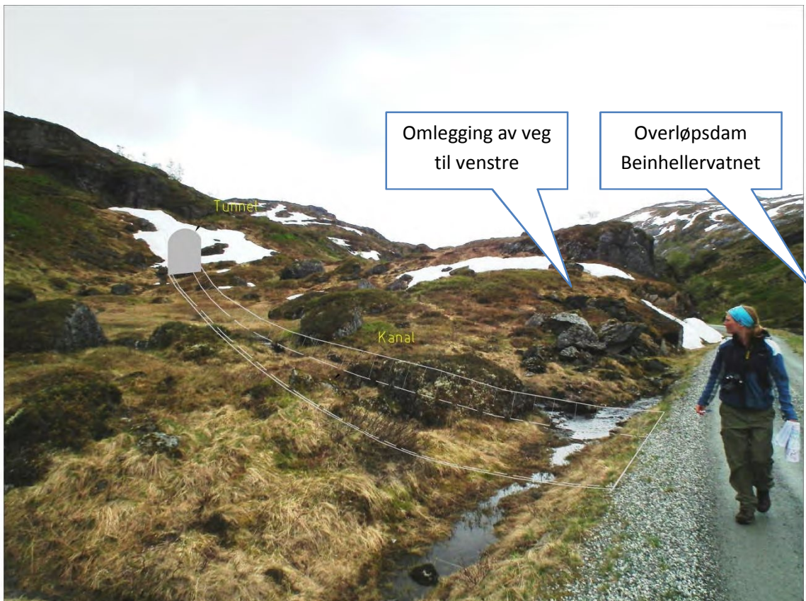
Figur 5: Overføringstunnel frå Kvanndalselvi på Beinhellersida. Det er planlagt ein kanal frå tunnelmunninga til Beinhellervatnet (som ligg utanfor høgre biletekant). Kanalen vil krysse vegen i ein kulvert. Dagens veg vil truleg måtte leggjast om for å få plass til damarbeidet.
