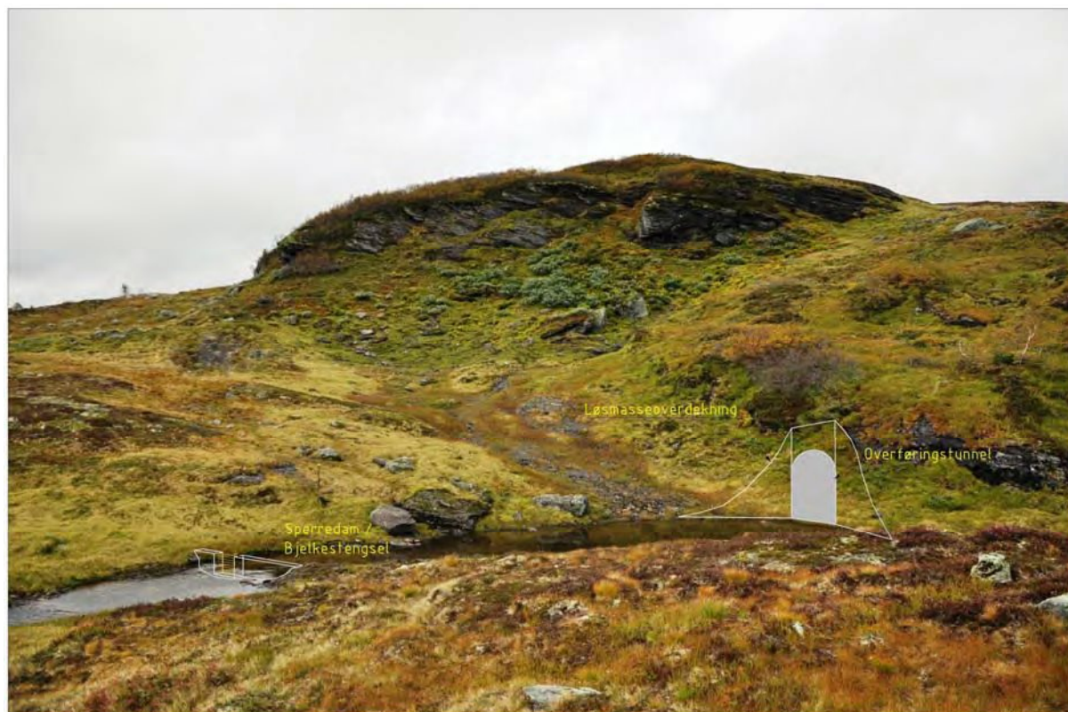
Figur 13: Overføring fra bekk i Urdadalen mot Kvanndalsvatnet
