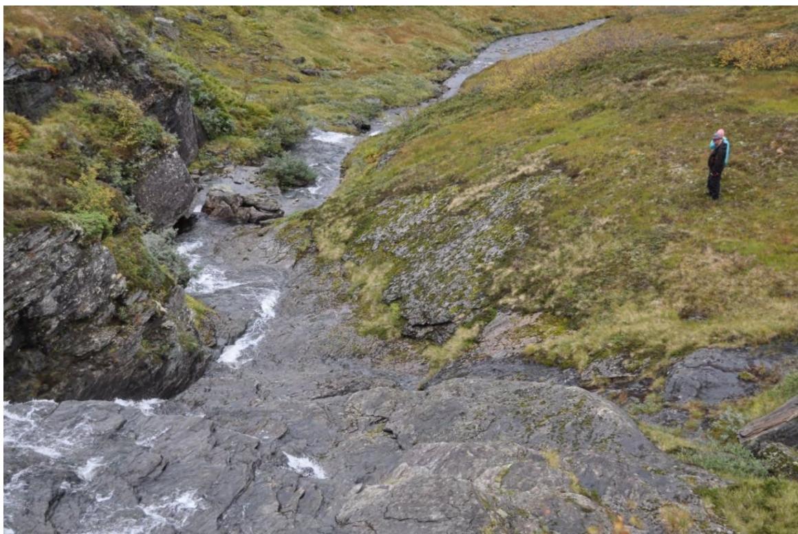
Figur 11: Like nedstraums overføringstunnel i Urdadalen. Elva renner vidare ned til Trefall. Vassføringa er her om lag 170 l/s.
