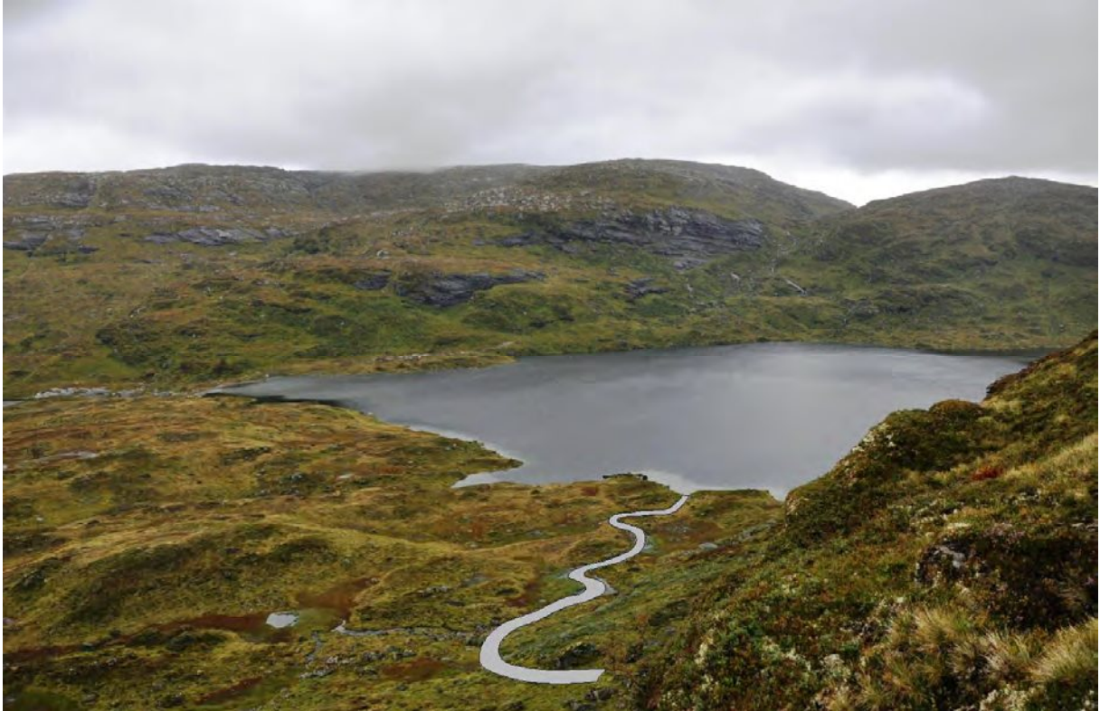
Figur 16: Illustrasjon av kanal til Kvanndalsvatnet frå tunnelen frå Urdadalen. Overskotsmassar frå tunnelen vil verte lagt langsmed kanalen. Det er ikkje planlagt nye permanente vegar eller kraftlinjer i området.
