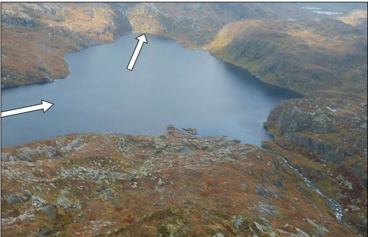
Figur 14. Nedre Blåvatnet sett mot nord. I bukta til venstre overføres vann fra Langavatnet via tunnel. I nordenden av innsjøen ledes vannet i en ny tunnel videre mot Beinhellervatnet. Ved utløpet nede til høyre bygges en ca. 7 m høy og 60 m lang dam. Innsjøen er planlagt regulert 5 m opp og 2 m ned i forhold til dagens vannstand. Foto: Bjart Are Hellen.
