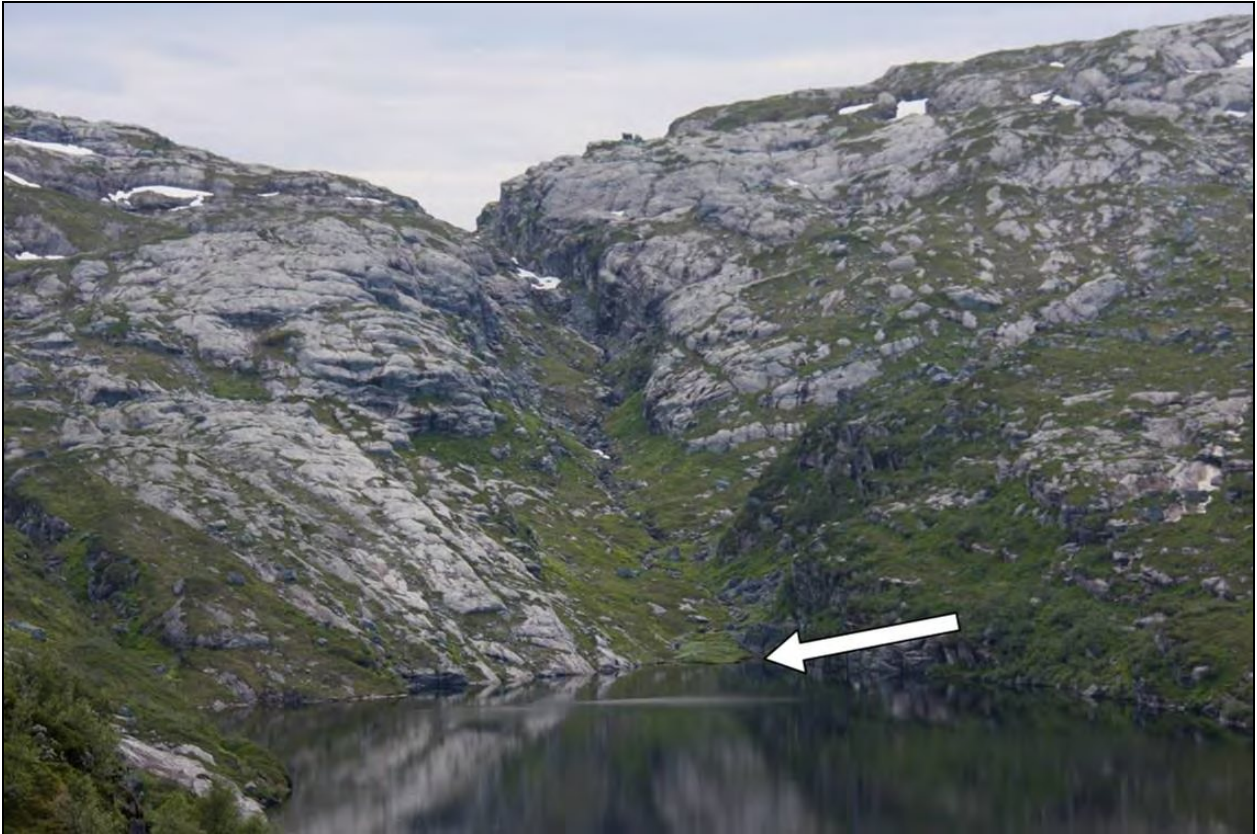
Figur 15. Sørvestre del av Nedre Blåvatnet, hvor vannet fra Langavatnet ledes inn via tunnel. Det skal bygges anleggsvei i strandsonen, under HRV, både mot sør og nord. Foto: Ole Kristian Spikkeland.
