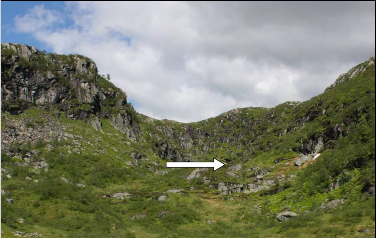
Figur 21. I Stemmedalen krysser vannveien fra Dyrabotn dalbunnen i retning Langavatnet. På grunn av manglende overdekning for tunnel, vil det bli anlagt en kanal/nedgravd rør. Foto: Ole Kr. Spikkeland.
