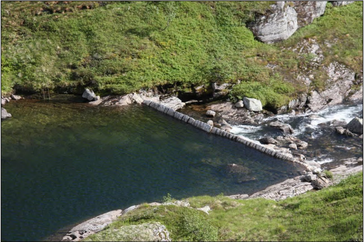
Figur 19. Eksisterende enkle dam i Langavatnet vil bli erstattet med en betongterskel. Det er ikke aktuelt å regulere innsjøen utover dagens naturlige vannstandsvariasjoner. Foto: Ole Kristian Spikkeland.
