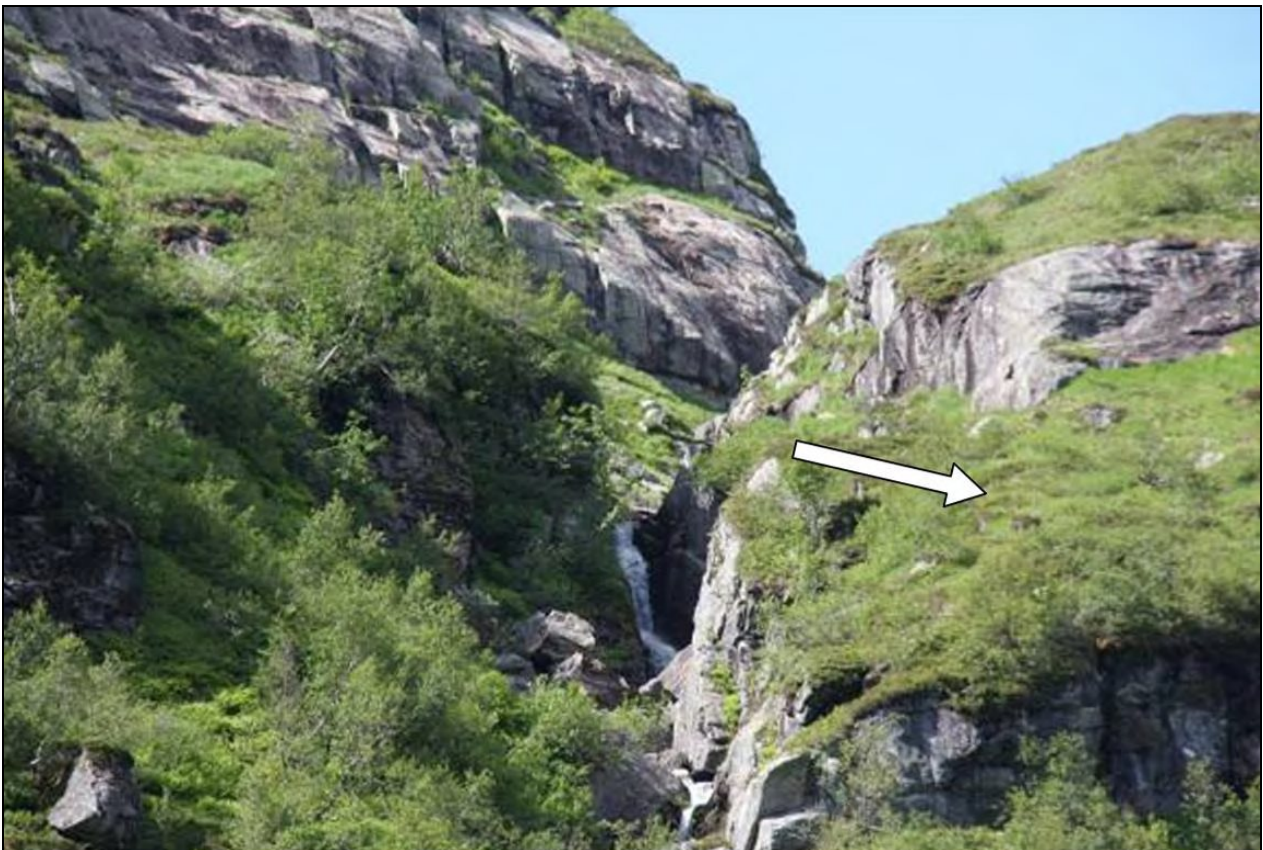
Figur 22. I Dyrabotn bygges bekkeinntak, hvorfra vannet føres i tunnel østover mot Stemmedalen og videre til Langavatnet. Foto: Ole Kristian Spikkeland.
