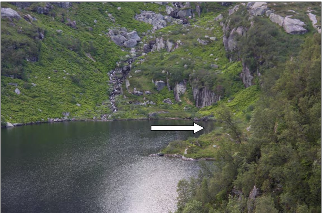
Figur 16. I nordenden av Nedre Blåvatnet ledes vannet i tunnel mot Beinhellervatnet. I bakgrunnen kommer bekken fra Øvre Blåvatnet inn. Foto: Ole Kristian Spikkeland.
