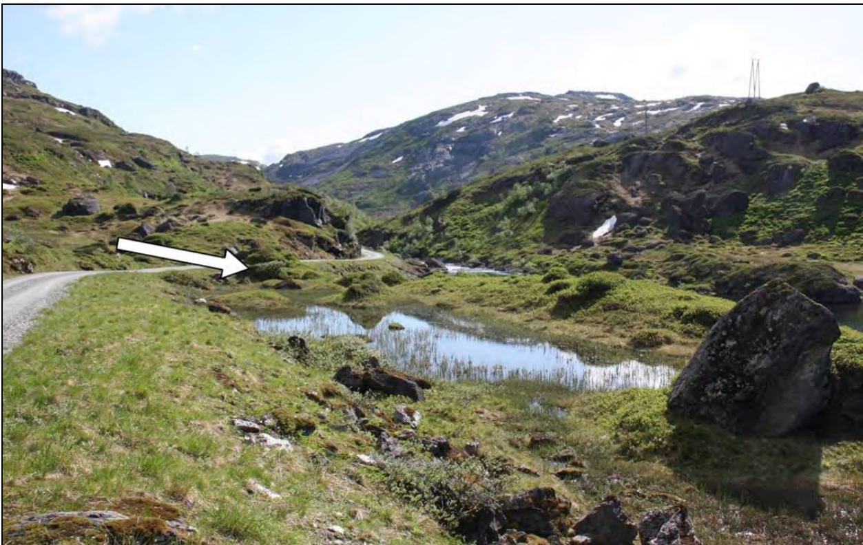
Figur 10. Nær utløpet av Nedre Beinhellervatnet (delvis skjult til høyre) vil en 80 m lang kanal/plastret elveløp lede vannet ned fra tunnelinnslaget mot Kvanndalselva. Kanalen vil krysse veien, og det kan her være aktuelt å heve/legge om veilegemet over en ca. 200 m lang strekning. Foto: Ole Kristian Spikkeland.
