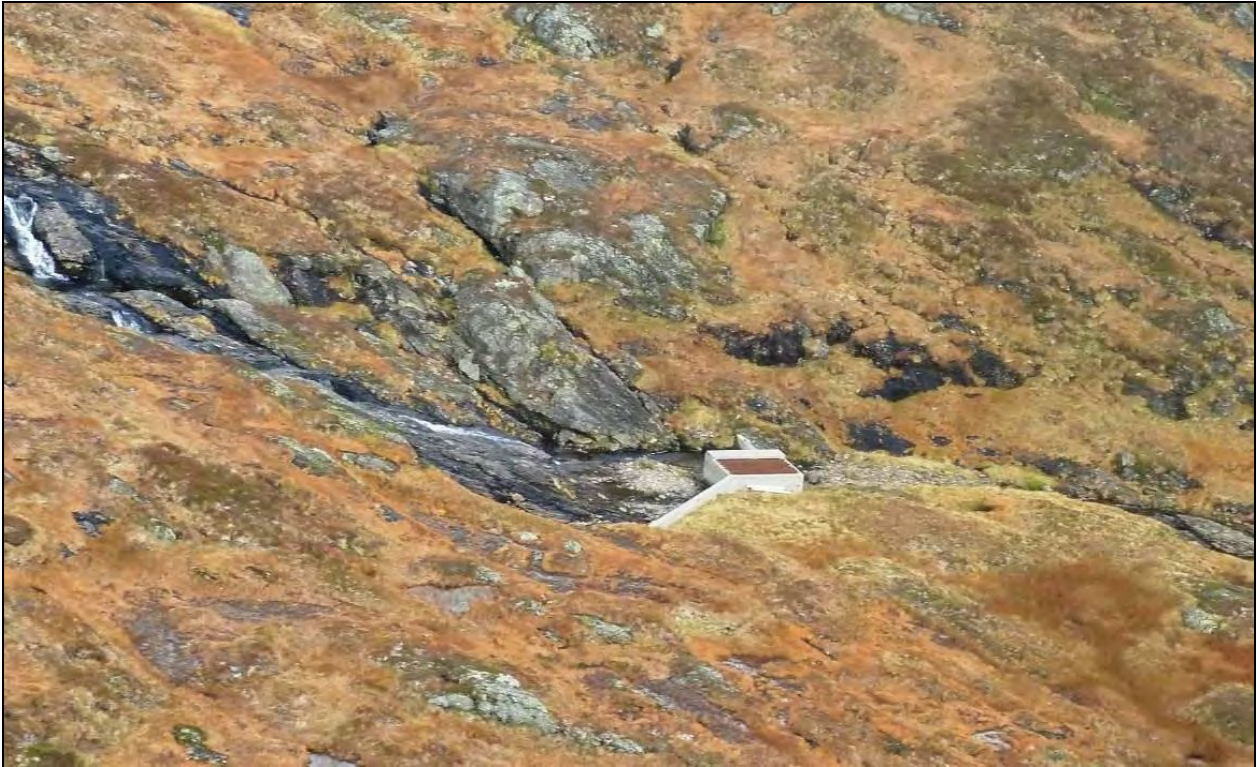
Figur 26. Beinhellerbekken, som har et felt på 1 km 2 , er allerede tatt inn på driftstunnelen til Evanger kraftverk. Foto: Bjart Are Hellen.
