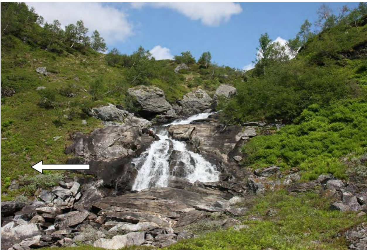
Figur 12. Kvanndalselva ca. 550 m nedstrøms Heimsta Kvanndalsvatnet overføres i tunnel mot Beinhellervatnet. Her vil det bli bygget et bekkeinntak Foto: Ole Kristian Spikkeland.
