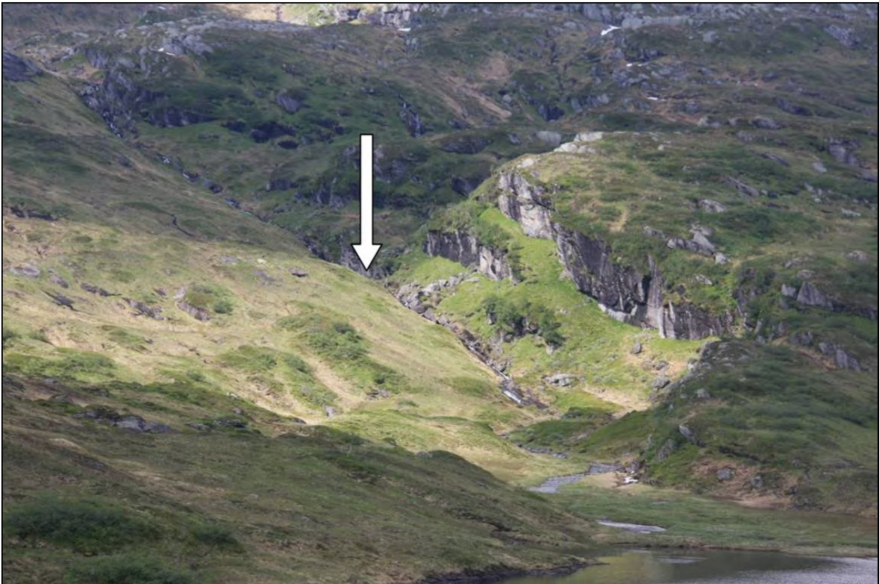
Figur 24. I denne nordlige tilløpsbekken til Heimsta Kvanndalsvatnet er det planlagt et bekkeinntak med fullprofilboret sjakt til driftstunnelen til Evanger kraftverk. Foto: Ole Kristian Spikkeland.
