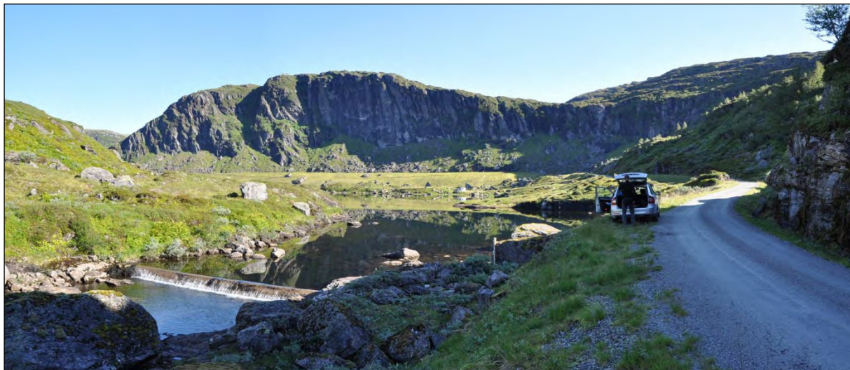
Bilde 26. Bilde av dagens dam ved Nedre Beinhellervann. Høyde opp til flatere parti til venstre for dammen kan derfor antas å være noe under 2 meter, en meter lavere enn planlagt dam.
