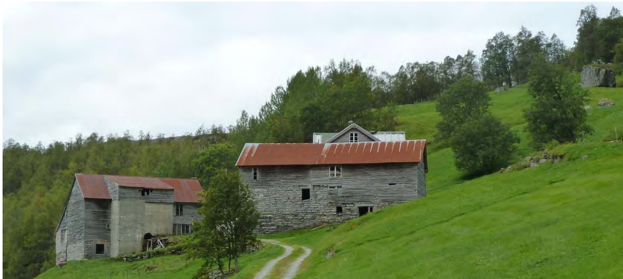
Figur 25. Det kulturhistoriske bygningsmiljøet på Fjellanger er autentisk og i bra stand. Det pågår restaureringsarbeid på våningshuset.
