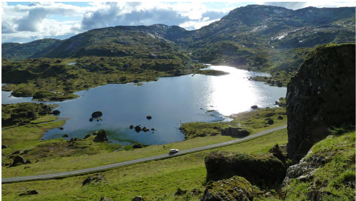
Figur 11. Utsyn fra Beinhelleren mot Beinhellerstølen på andre siden av Øvre Beinhellervatnet. Eksisterende veg ligger oppå massedeponiet som strekker seg helt ned til vatnet.
