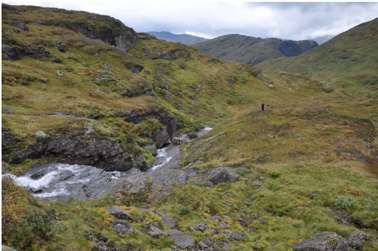
Urdadalen ved bekkeinntaket. Vannføringen er ca. 0,17 m 3 /s. Dato 8. september 2011 kl. 11.
