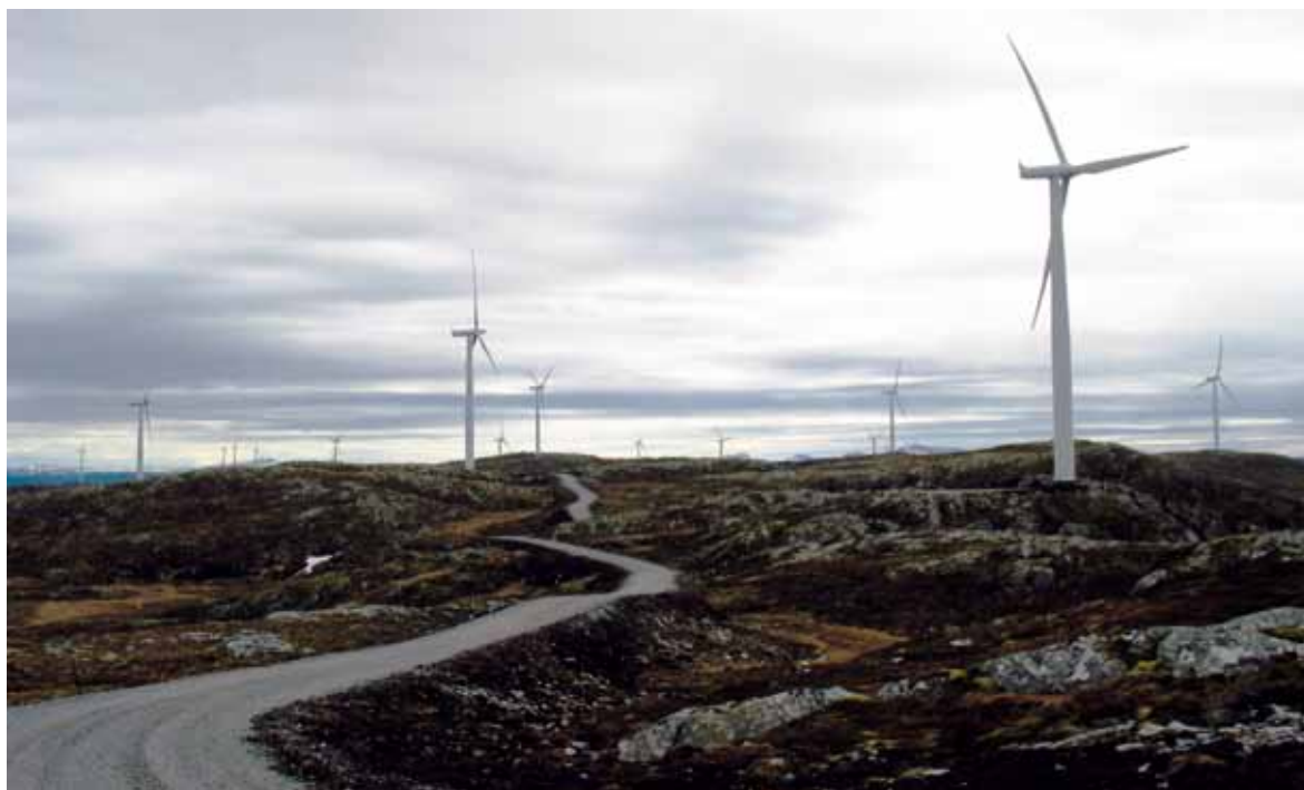
Figur 3. Eksempel på vindturbiner som kan være egnet for et vindkraftprosjekt på Eggjafjellet/Åsfjellet. Tårnet i aktuelle vindturbiner er cirka 80-120 meter høyt og hvert vingebled er cirka 40-60 meter langt. Foto av Hitra vindkraftverk: Sweco.
