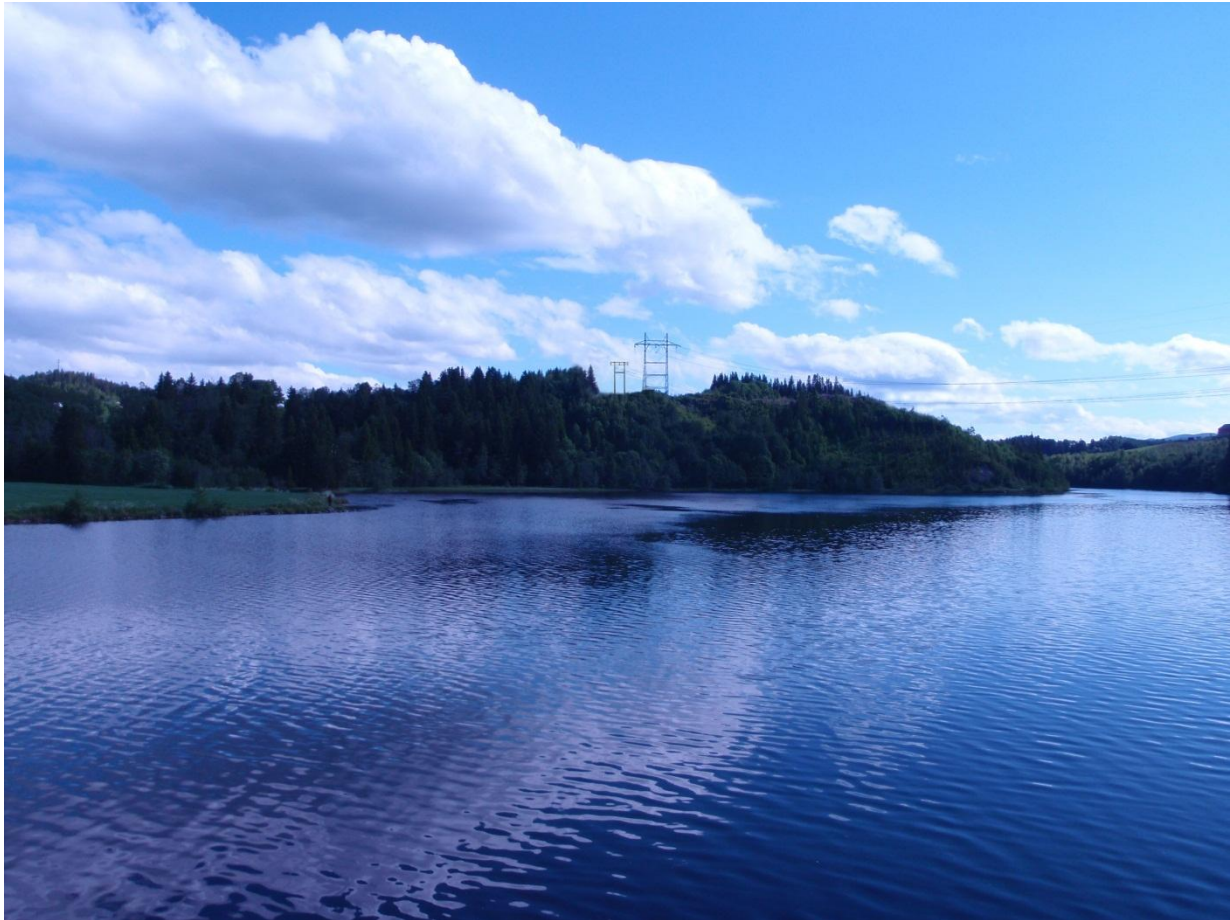
Figur 6-10 Visualisering av nettraseen ved Tanem. Masten til venstre er den planlagte 132 kV linjen, mens masten til høyre er den eksisterende 420 kV linjen. Fotomontasje: Sweco.
