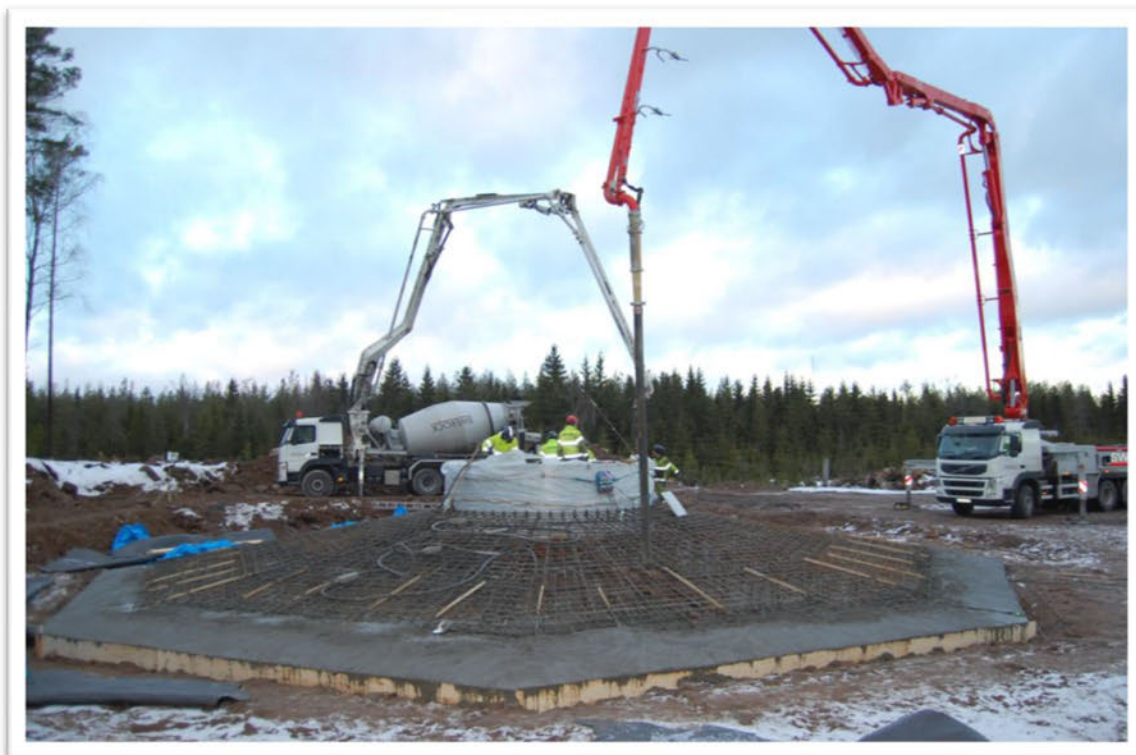
Figur 6-6: Støping av gravitasjonsfundament. Foto E.ON Vind
