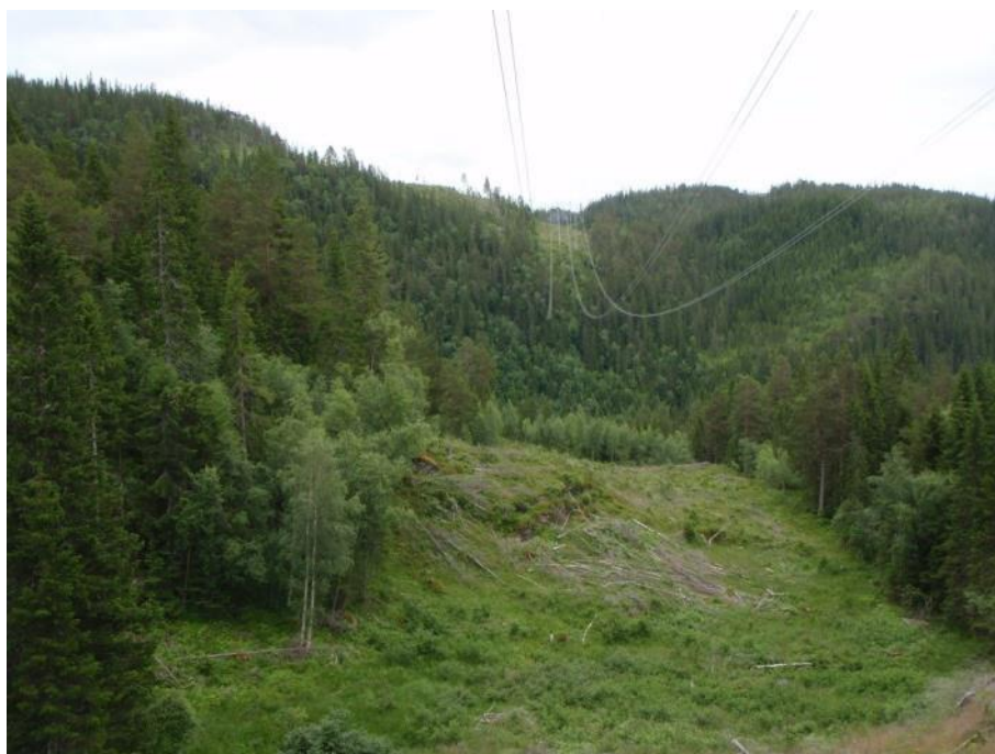
Figur 8-12. Eksisterende kraftledning gjennom Stabbmarka. Bildet er tatt sørøstover fra Eggåsen. Foto: Solveig Angell-Petersen, Sweco.
