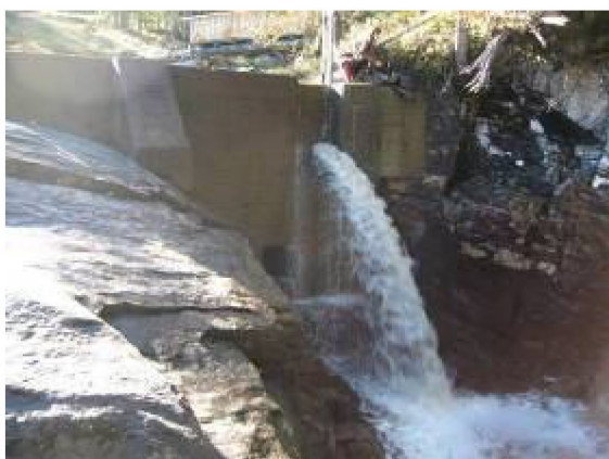
Bilde 25: Minstevannsslipp Nørståe I. Foto: Elvekraft
