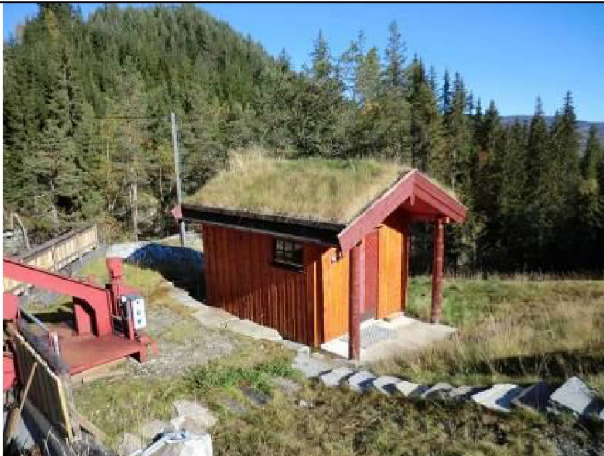
Bilde 3: Pumpehus, planlagt type. Foto: Elvekraft.
