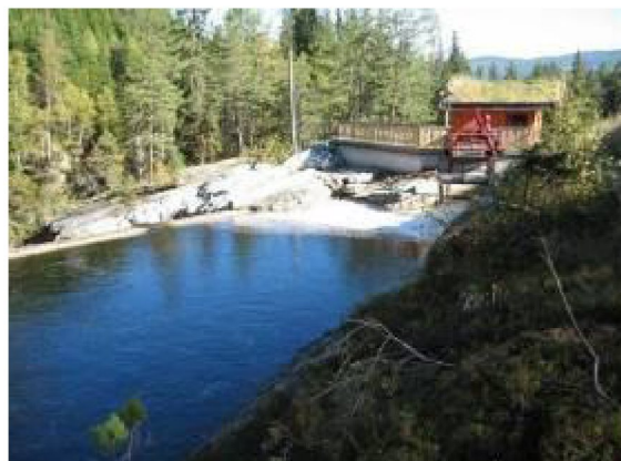
Bilde 24: Inntaksbasseng Nørståe I. Foto: Elvekraft
