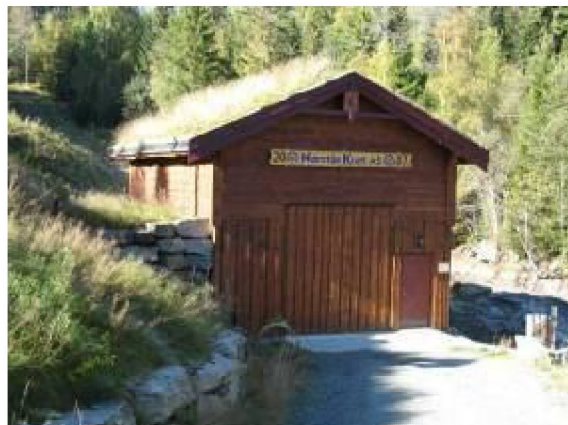
Bilde 22: Kraftstasjon Nørståe I. Foto: Elvekraft
