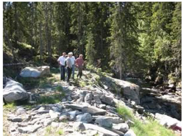
Bilde 5: Rørtrasé ovenfor stasjon. Foto: Elvekraft
