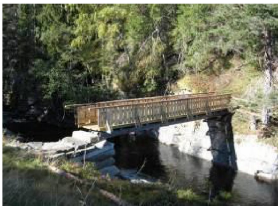
Bilde 23: Gangbru oppstrøms demning til Nørståe I. Foto: Elvekraft
