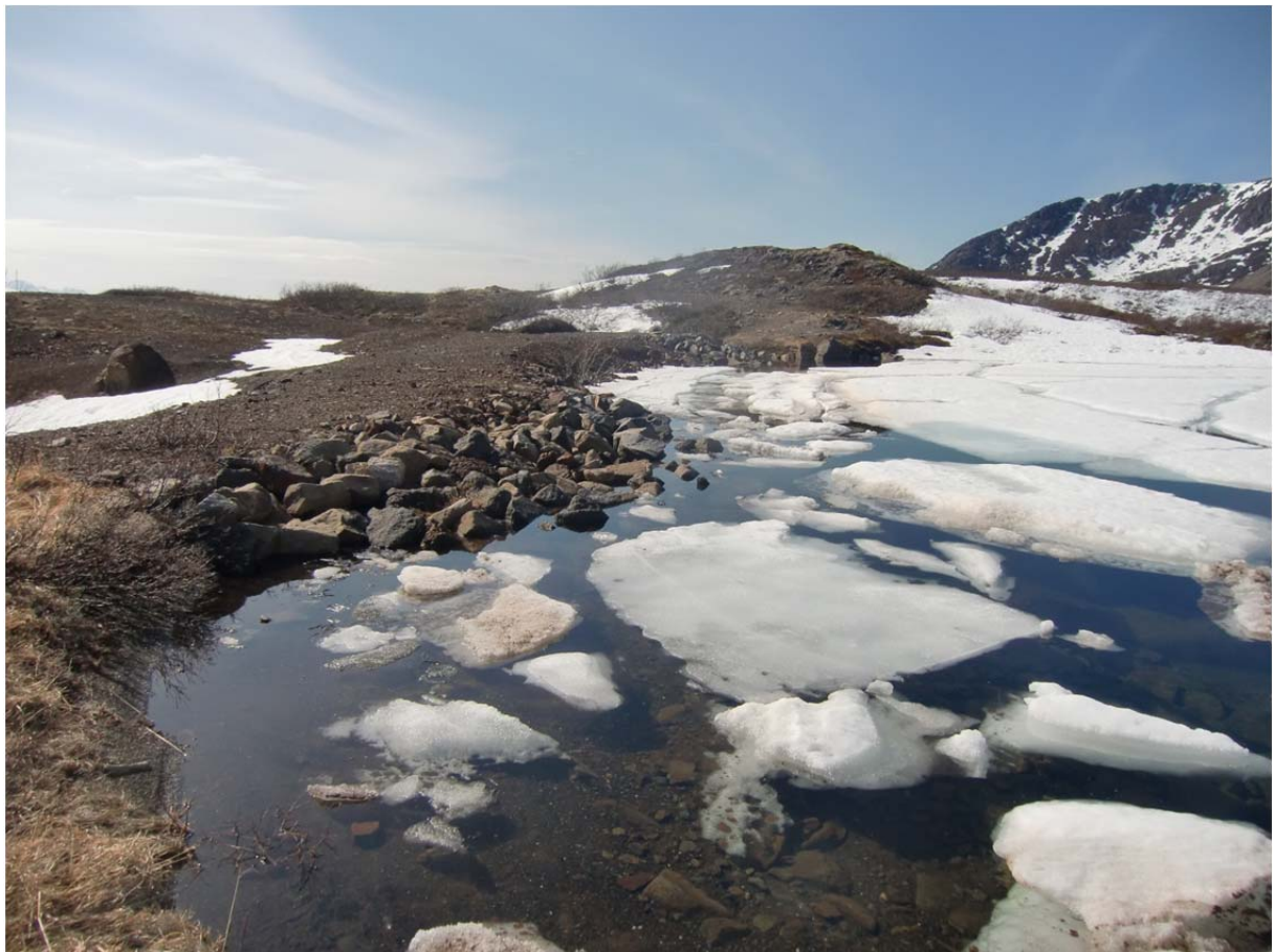
Bilde 6: Jordfyllingsdam sett mot SV.
