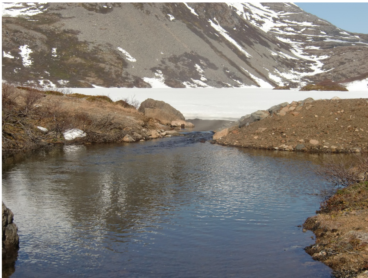
Figur 3: Jorddam ved utløpet av Korsvikvannet
