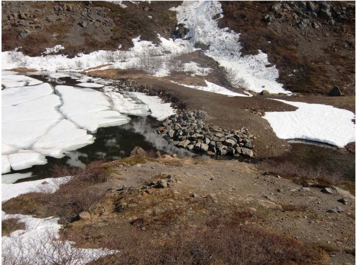
Bilde 5: Overløp i jordfyllingsdam sett mot Ø.
