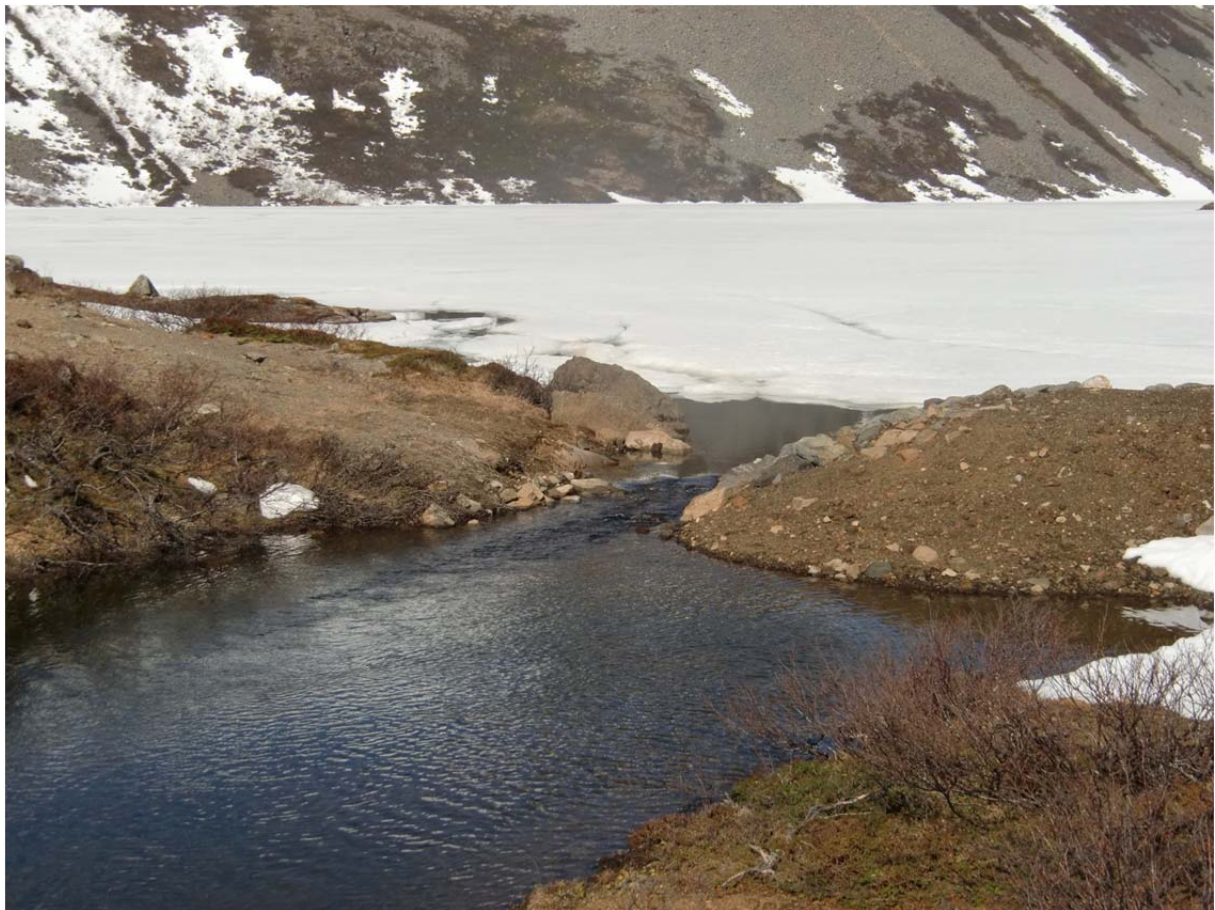
Bilde 7: Overløp i jordfyllingsdam.
