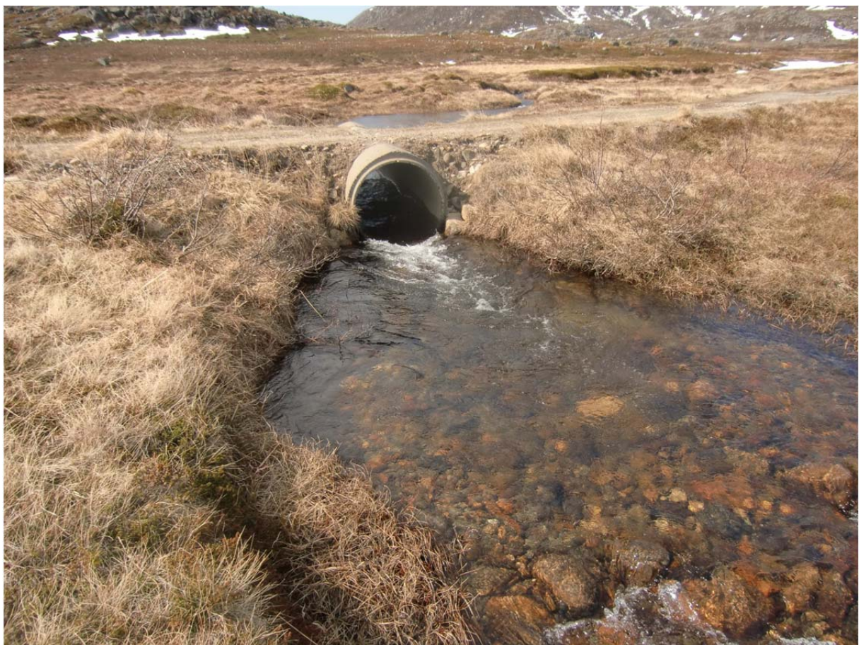
Bilde 8: Stikkrenne under eksisterende adkomstveg.
