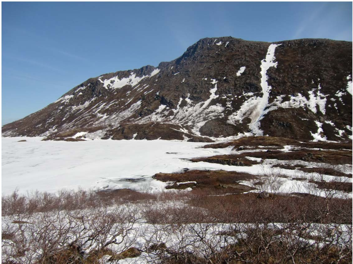
Bilde 2: Jordfyllingsdam sett mot Ø.
