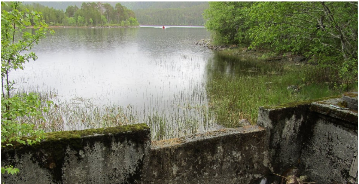
Figur 1. Bildet viser demningen i Søvatnet. Som en ser så er vannstanden under overløpet, og Søvassbekken er dermed tørr. Vannstanden kan reguleres v.h.j.a. planker i utsparringen og opp til øvre murkant, dvs 30 cm over det som er etablert som en normalvannstand.
