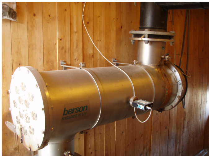
Figur 9 UV-behandling av sjøvann
