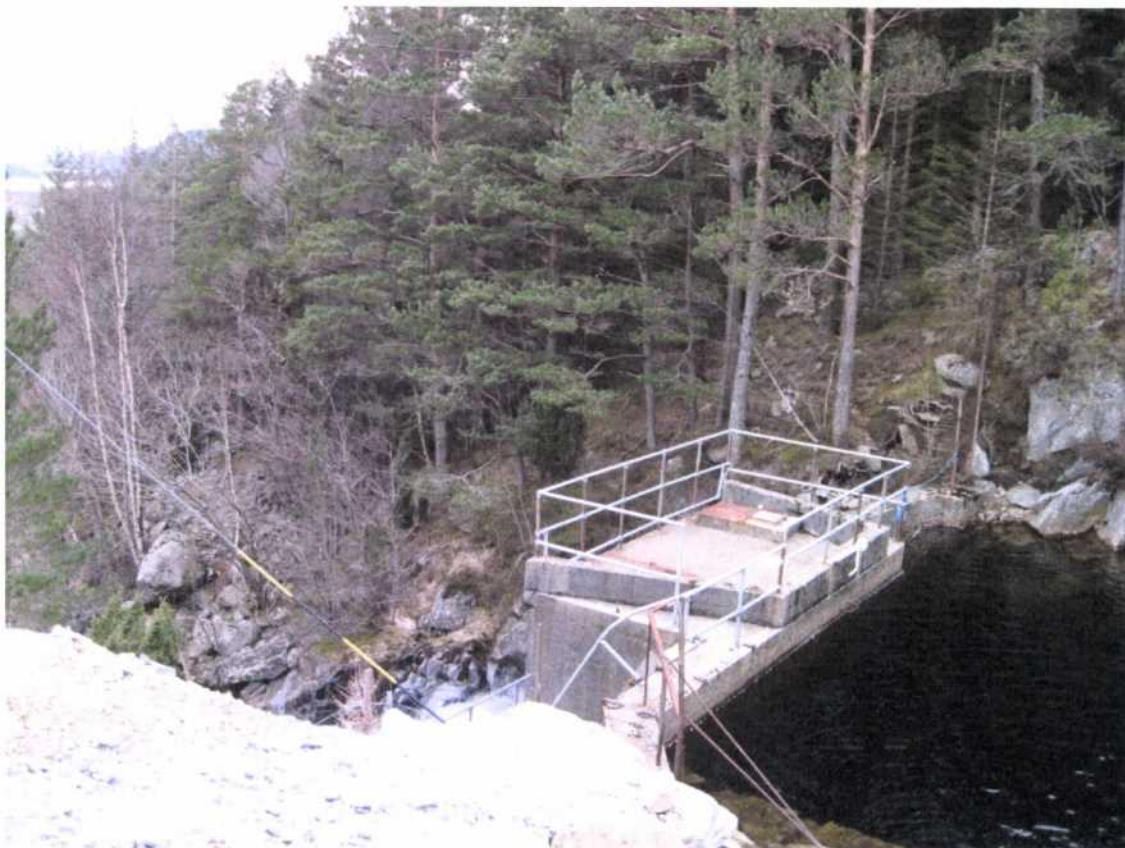
Inntaksdammen sett øvan i frå. Den strekkjer seg 20 meter inn/bakover i terrenget, er 2 meter djup og 10 meter brei.
