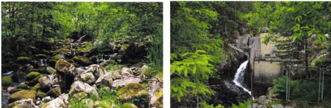
Figur 3. Området for utløpet av Auno kraftverk til venstre og inntaksdammen til høgre.
