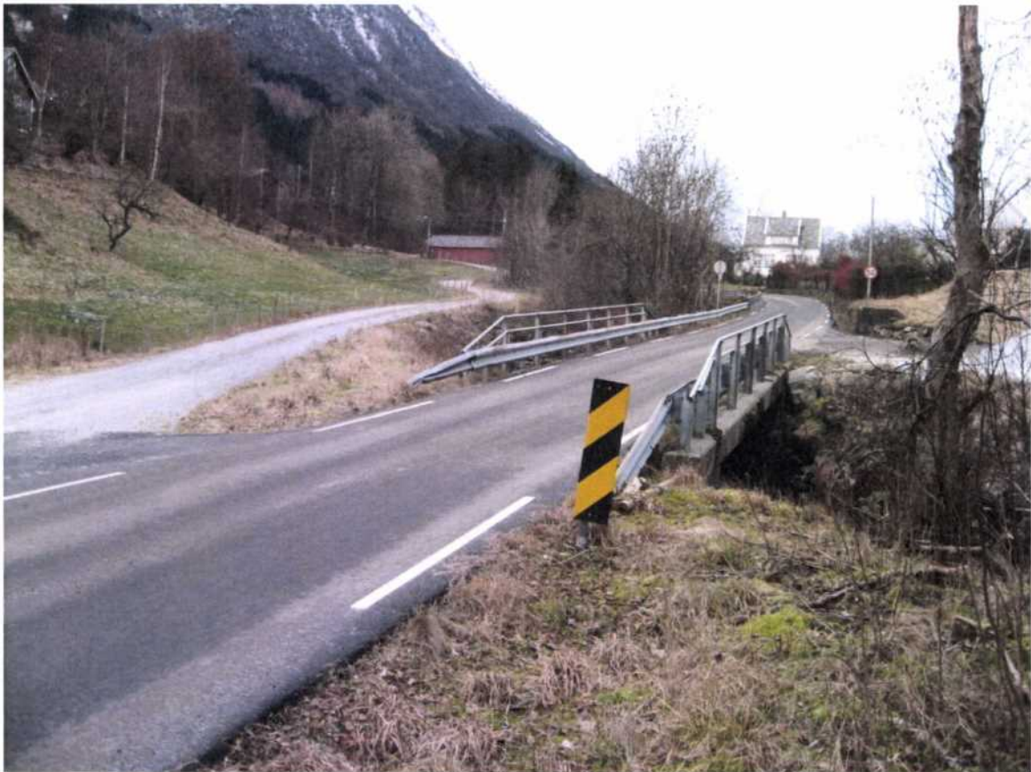
Vegen ned til punktet det er planlagt å krysse fylkesveg 40. Vidare her i frå vil ein leggje røyr gata på andre sida av elva.
