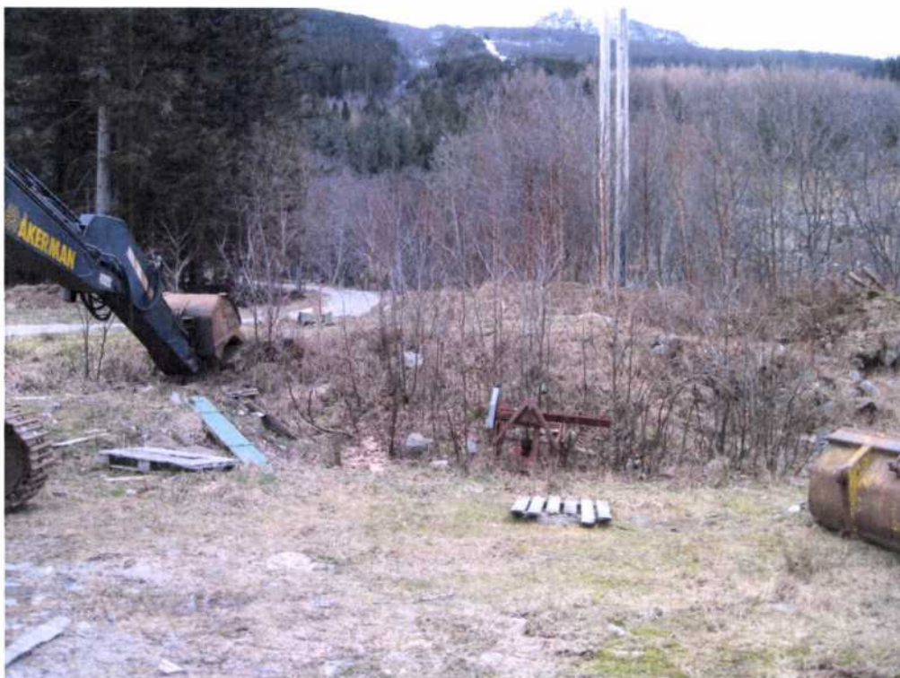
Vidare nedover rørgate trassen sett nedanføre.
