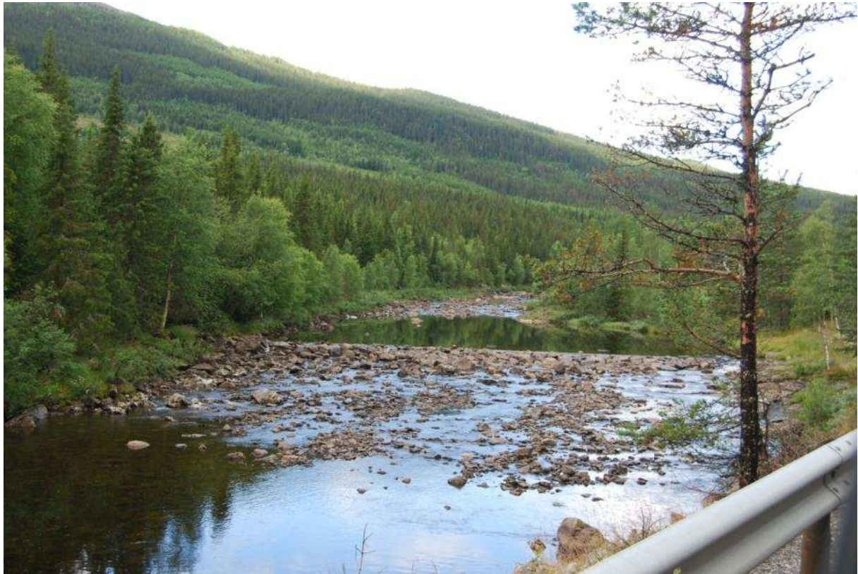
Målt 435 l/s sluppet fra Eikredammen. Fremdeles en del resttilsig fra regnværet dagen før.
