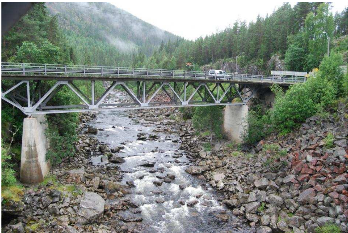
Estimert 320 l/s sluppet fra Eikredammen. Regnvær gir økt resttilsig.
