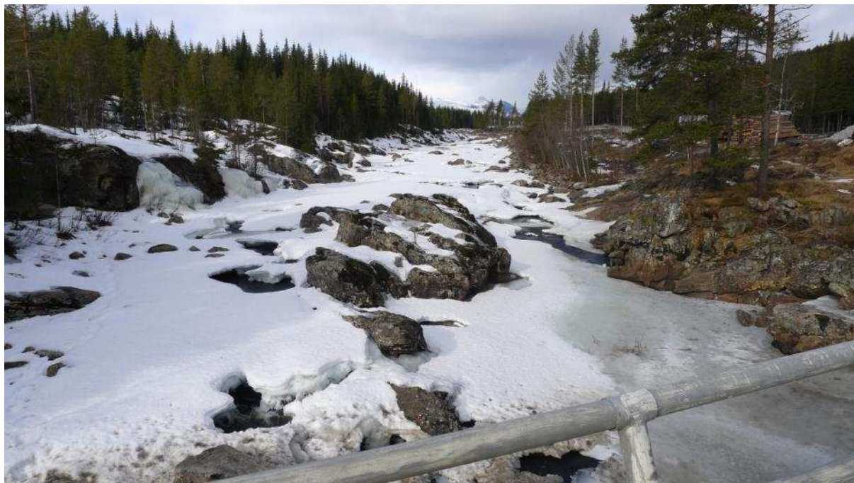
25 l/s sluppet fra Eikredammen. Selvpålagt minstevannføring om vinteren.
