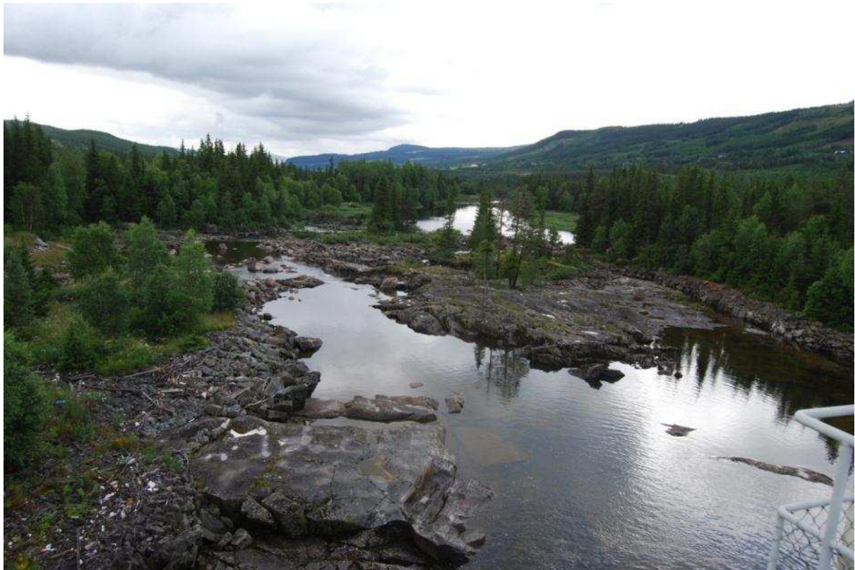
Målt 435 l/s sluppet fra Eikredammen.
