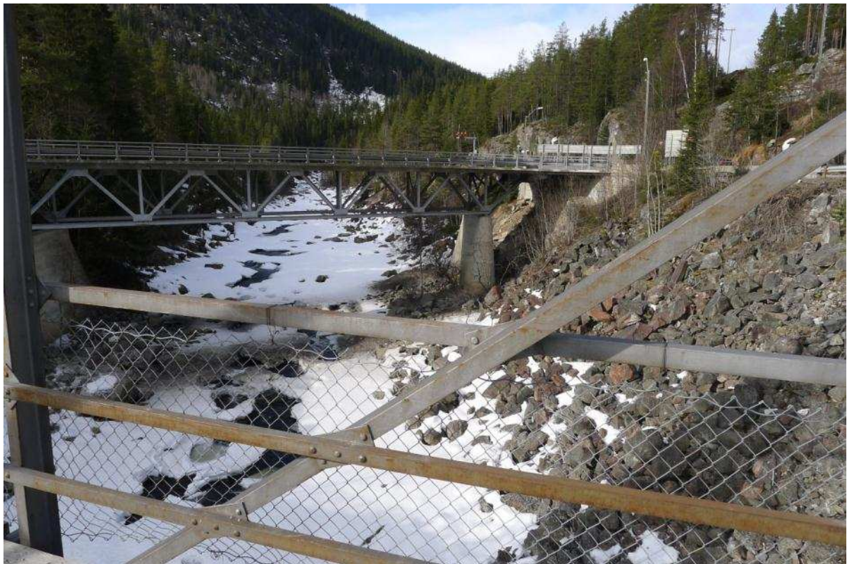
25 l/s sluppet fra Eikredammen. Selvpålagt minstevannføring om vinteren.
