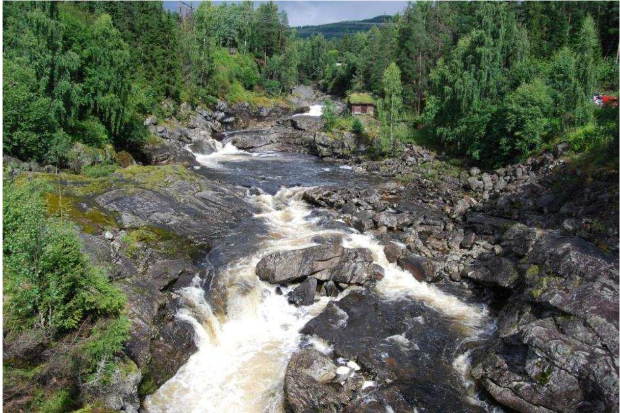
Målt 435 l/s sluppet fra Eikredammen. Vannføring ved Hesla bru målt til 7600 l/s. Fremdeles økt resttilsig på grunn av regnvær dagen før.
