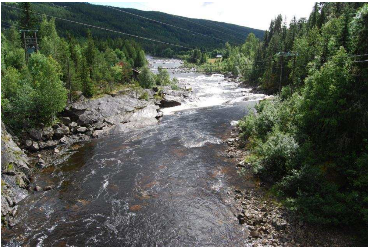
Målt 435 l/s sluppet fra Eikredammen. Økt resttilsig på grunn av regnvær dagen før.
