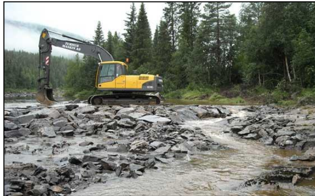
Fig. 1. Terskelbygging i Hemsil nedenfor Eikredammen ble gjennomført i perioden 2008-2010. Foto: E-CO Energi.
