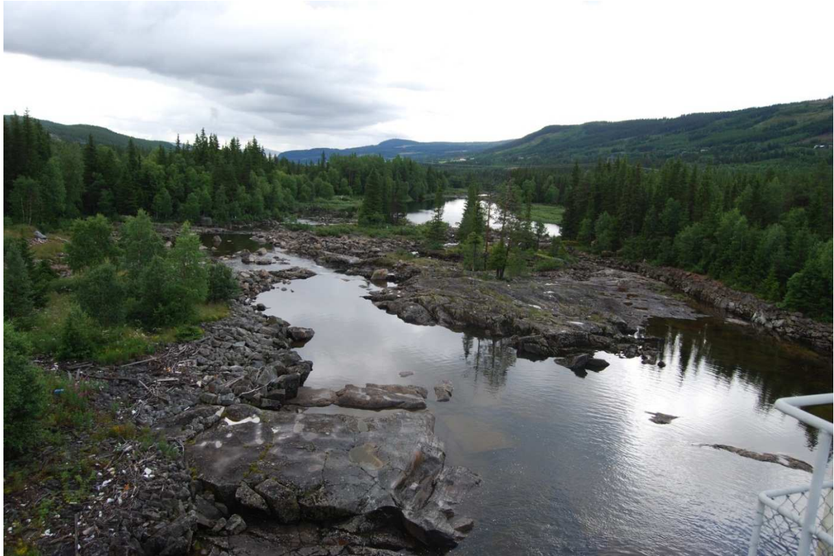
Målt 435 l/s sluppet fra Eikredammen.
