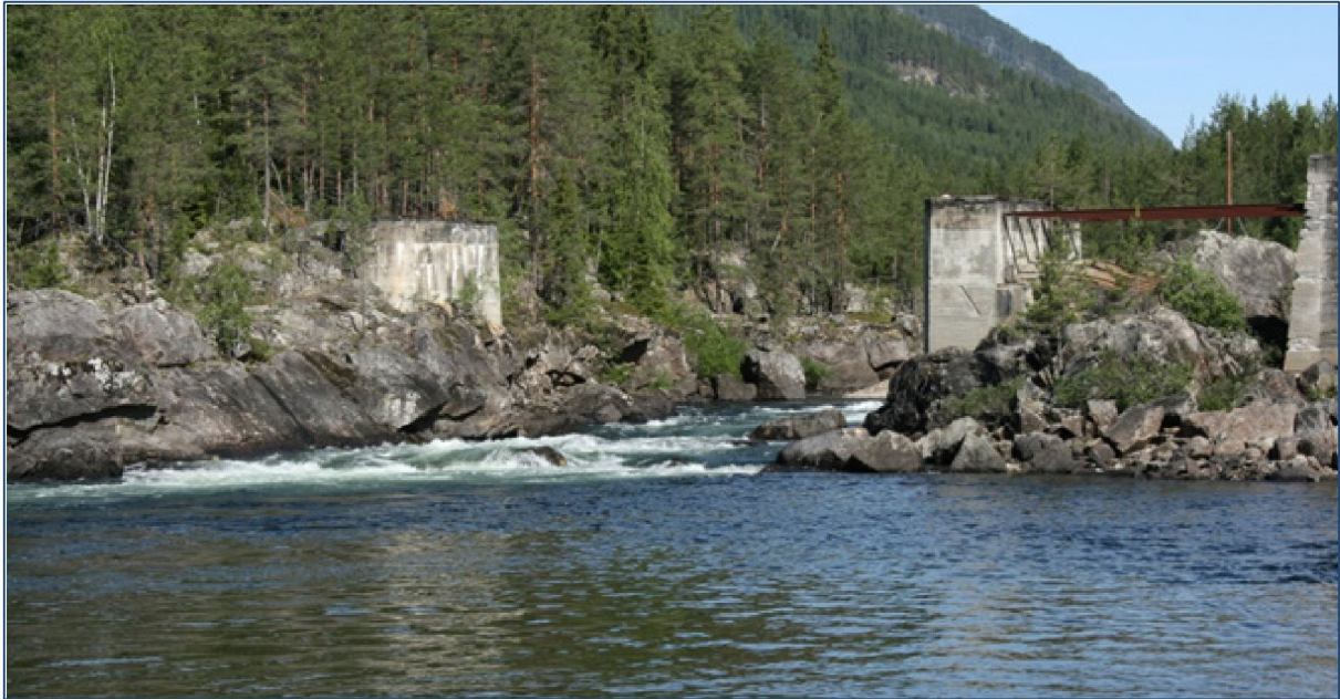
Figur 4-13: Endret vannstand vil kunne få innvirkning på det tekniske kulturminnet Falkenhorst bru ved svært lav eller svært høy vannføring. Foto E-CO
