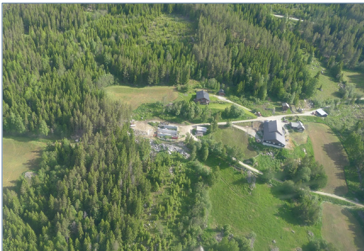
Figur 4-6: Planlagt midlertidig depot ligger omtrent midt i bildet, i skjul mellom trekkene i skråning med eksisterende fyllmasser rett nedenfor nyoppført driftsbygning. Foto: E-CO.
