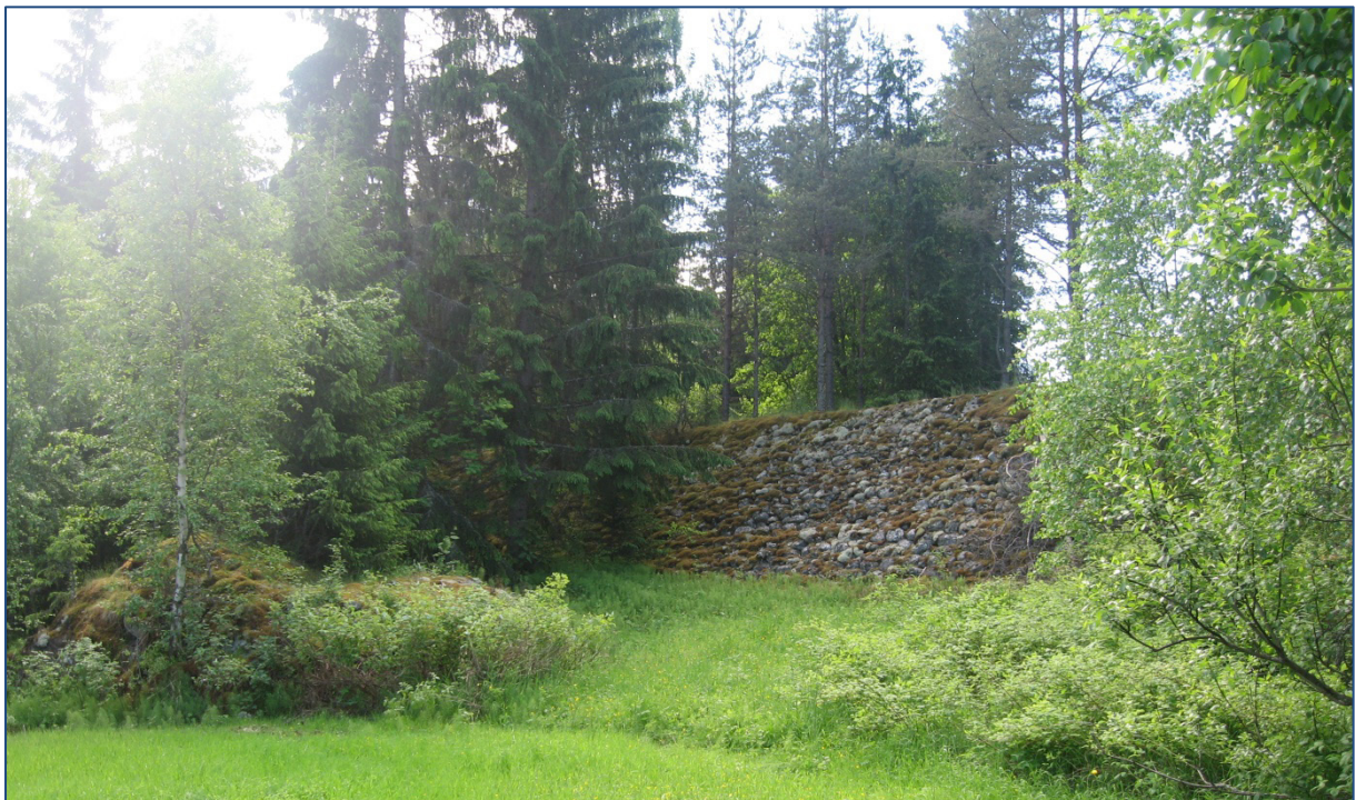
Figur 4-11: Fundamentene av Falkenhorst bru i form av tørrmur og betong på vestsiden av elva. Foto: NIKU.
