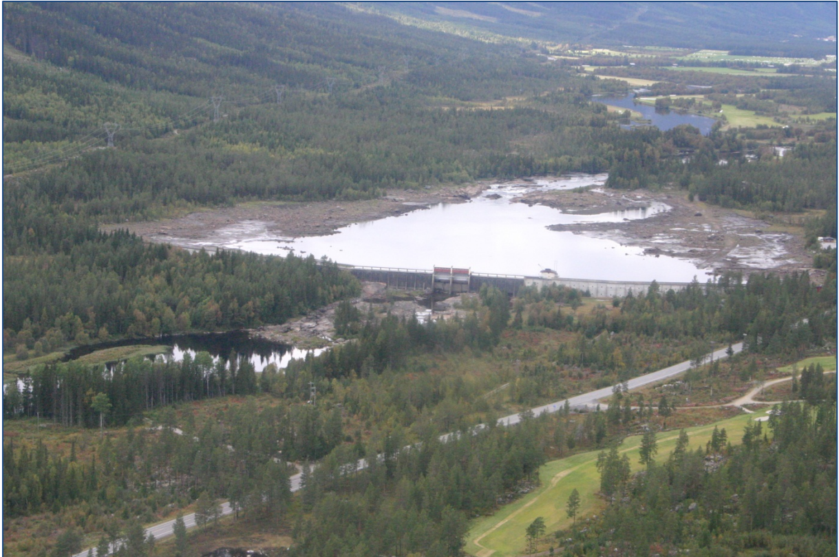
Figur 4-1: Eikredammen sett mot nord. Foto: E-CO.
