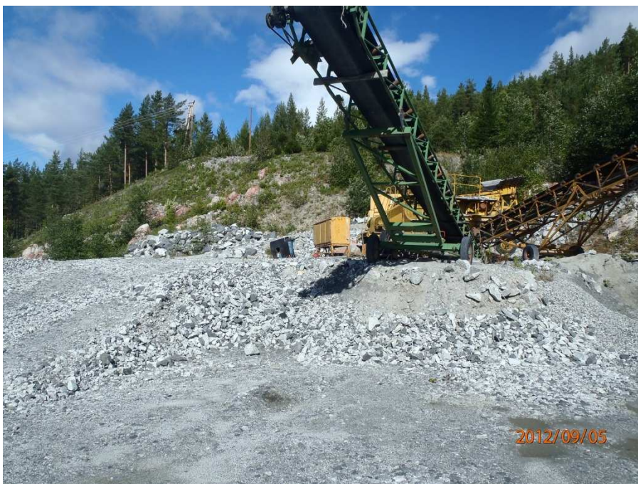
Tipp 4-16 Tipp Skredderberget er i drift som grustak i dag
