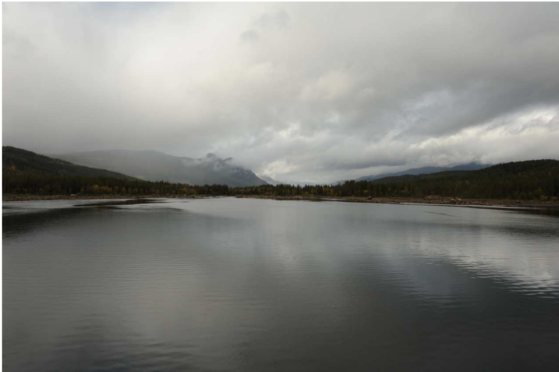
Figur 4-5 Eikredammen sett fra dammen mot nord. 18. september 2012.
