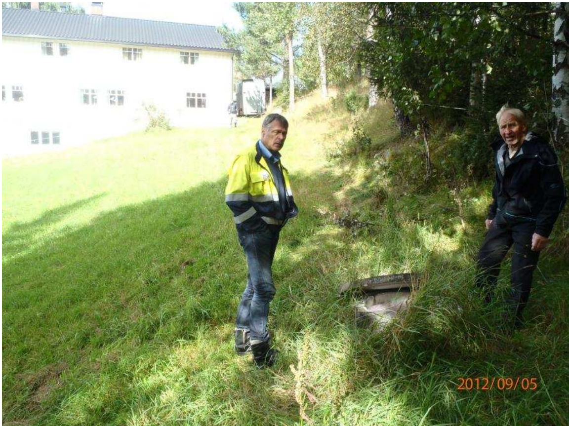
Figur 11 Grunnvannsbrønn ved Åsgardan. Denne ble boret etter at eksisterende tunnel ble drevet, da den gamle bønnen gikk tørr etter tunneldrivingen. Den nye brønnen er boret ned 120 m.
