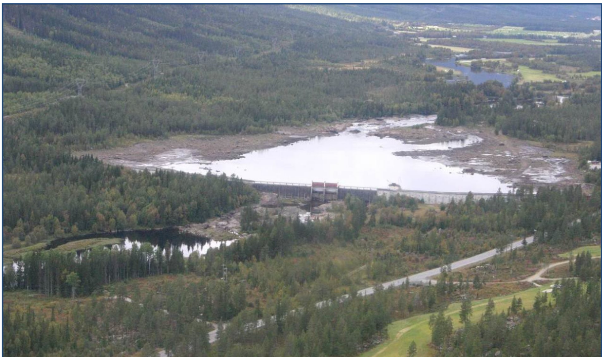
Figur 12-1: Eikredammen sett mot nord. Foto: E-CO.
