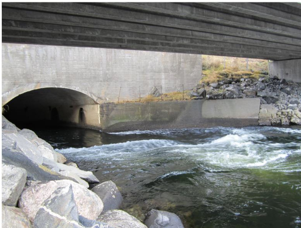
Figur 2-2 Dagens utløp fra Hemsil 2 til venstre, brudekke for Rv 7 og brufundament for Rv 7 til høyre. Nytt avløp vil ligge til høyre for utløpet fra Hemsil 2.
