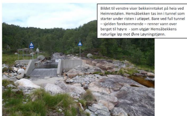
Bekkeinntaket i Hemså, like oppstrøms øvre Løyntjønn
