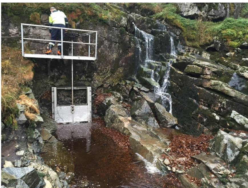
Figur 3.9 Bekkeinntak Furelibekken (foto tatt av AEVK 11.5.2015 under inspeksjon av luke)
