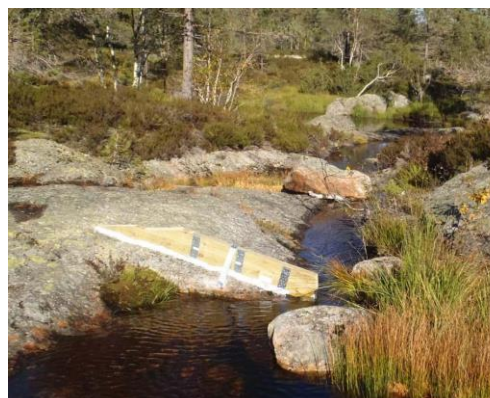
Utløpet av øvre Løyntjønn hvor det er etablert en liten terskel med et egnet overløpsprofil
