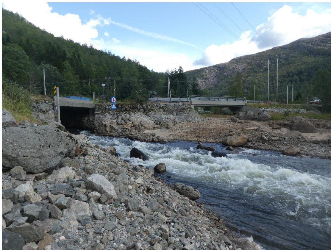
Foto 5.1 Bjørnestadvatn v/utløp fra Osen kraftverk ca kote 349,4 moh (14.18.2018, AEVK)
