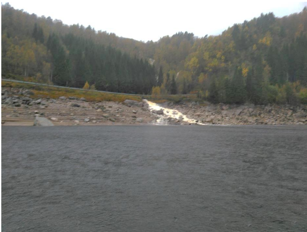
Bilder 4.1. Nespervatnet var betydelig nedtappet på undersøkelsestidspunktet. Kraftig regnværsperiode førte derimot til gradvis og rask vannstandsøkning mens undersøkelsene pågikk.
