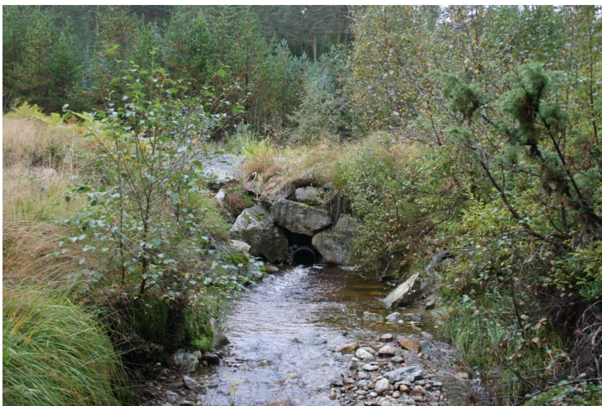
Bilde 8.2. Parti fra innløpsbekken til Nedre Løyntjønn som har partier med egnet substrat. Røret under veien ligger dypt og synes ikke å ha oppgangshindrende effekt. Tilgjengelig gyteareal oppstrøms vei er begrenset. Bildet fra 2013.
