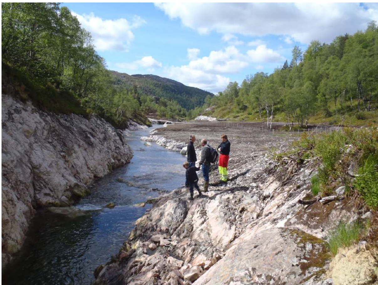
Nytt bekkeløp og terreng sett fra oppstrøms side. Energiknuserterskel til v. for gruppen.
