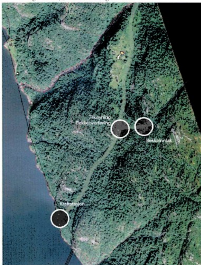
Figur 23: Rørgatetrasé sett ovenfra. Merk at rørgata i stor grad følger et dalsøkk i terrenget, og i derfor stor grad vil bli skjult for innsyn fra fjorden. Nedre del blir synlig fra ståsted midt i fjorden. Revegetering vil skje raskt i de synlige områdene, som går gjennom skog med høy bonitet.
