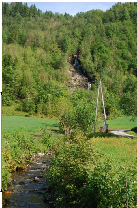
Oversikt frå vegen i sør. Røyrsgata og kraftstasjonen er tenkt på austsida av Skeisbekken som er omkrinsa av vegetasjon heile vegen. Såret i midten av bilete kom vinteren 2011 etter snø- og isskred.
