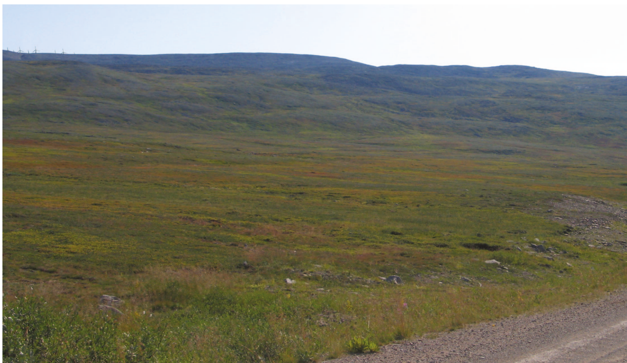
Figur 14 Vindparken sett fra Syltefjorddalen (120 MW)
