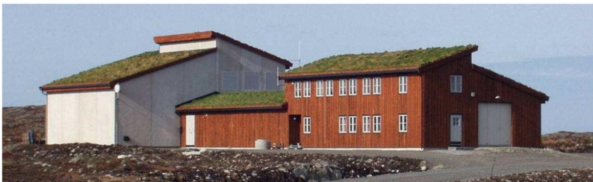
Figur 3-4 Eksempel på kombinert servicebygg og transformatorstasjon. (Statkraft SF sitt anlegg ved Smøla vindpark).
