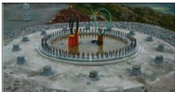
Figur 8. Fundament for 2,3 MW vindturbiner.
