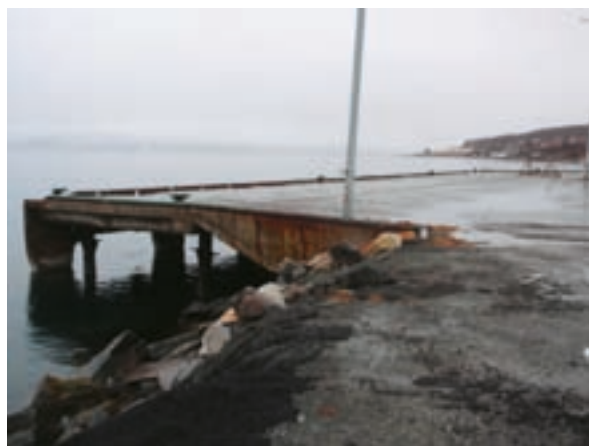
Figur 6; Kaianlegg i Olderdalen for ilandføring av kran og turbiner.
