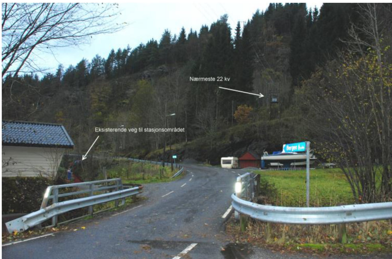
Figur 2 – Bro over Aldalselva, nærmeste tilknytningspunkt til 22 kV, og eksisterende veg ned til kraftstasjonen
