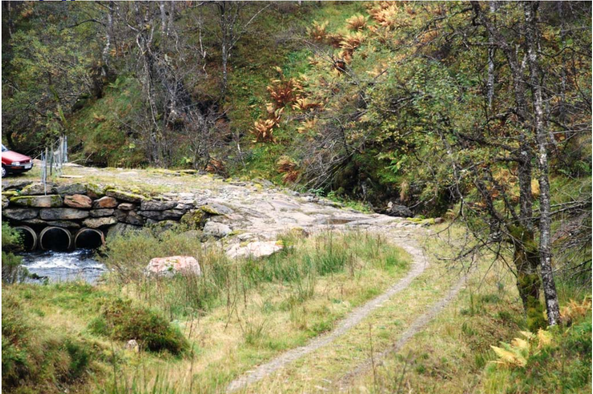
Bilde 1.1 Eksisterende vei opp til dam og inntak
