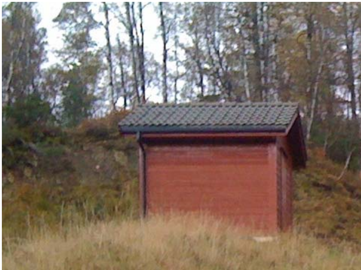
Bilde 7.3 Hus for vannverk
