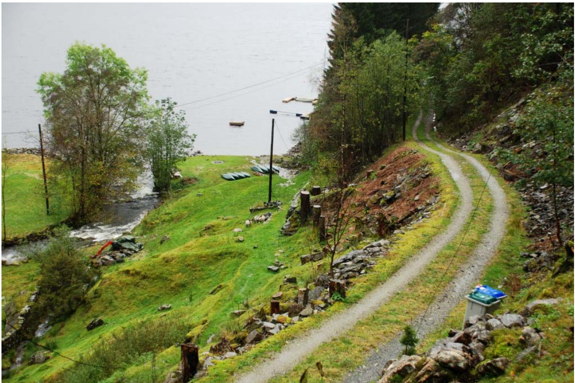
Bilde 1.2 Eksisterende vei til kraftstasjonen
