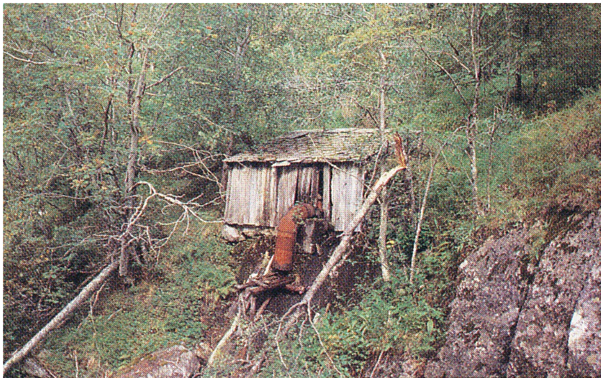
Bilde 7.2 Rester av gammelt kraftverk
