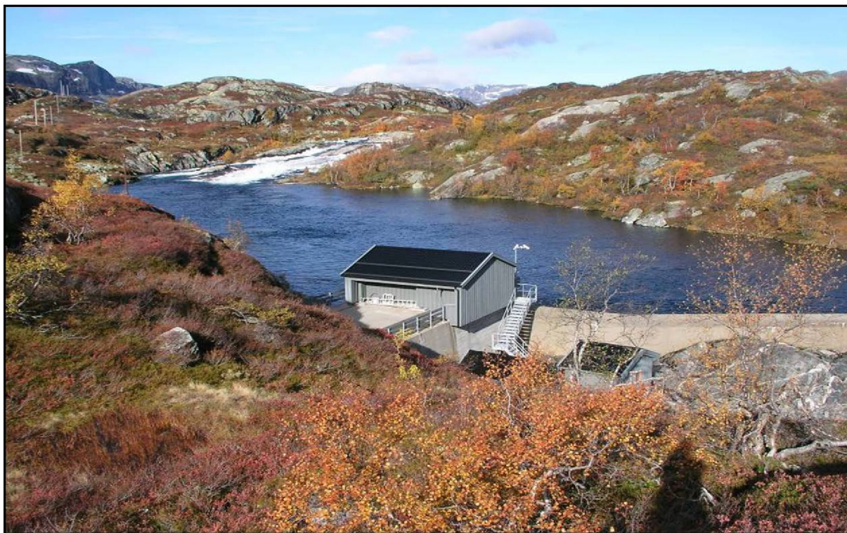
Figur 3.1 Inntaket i Kjela nedstrøms Vesle Kjela. Inntaksdam for overføringstunnel til Førsvatnet. Stryket som får redusert vannføring sees i bakgrunnen.
